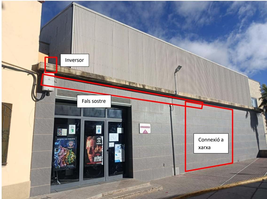
Imatge 11. Distribució de cablejat d'alterna
