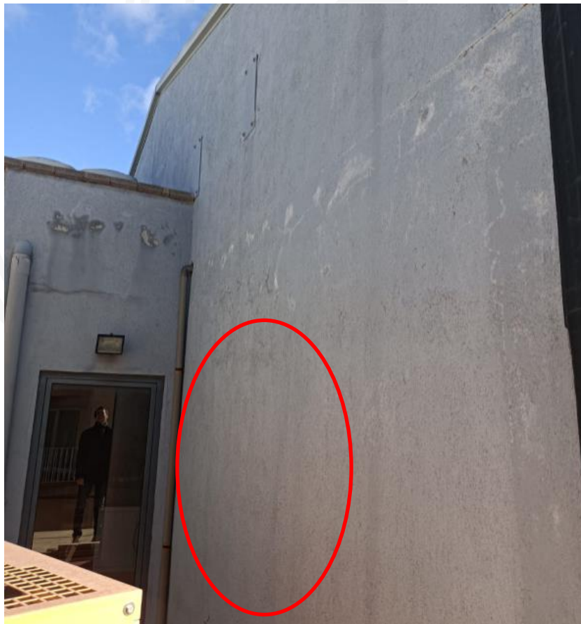
Imatge 10. Ubicació de l'inversor i proteccions
