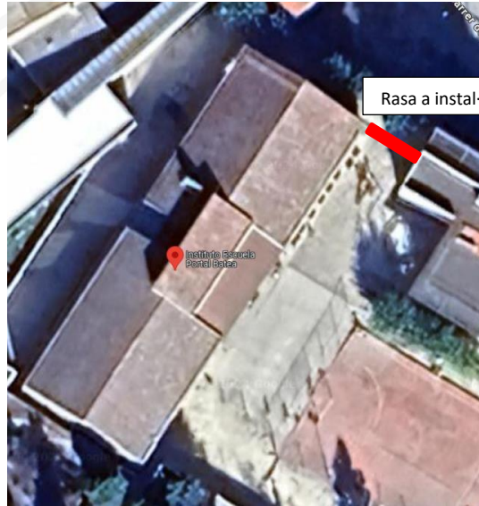
Imatge 14. Detall de la rasa a construir per fer passar el cablejat de CA.
