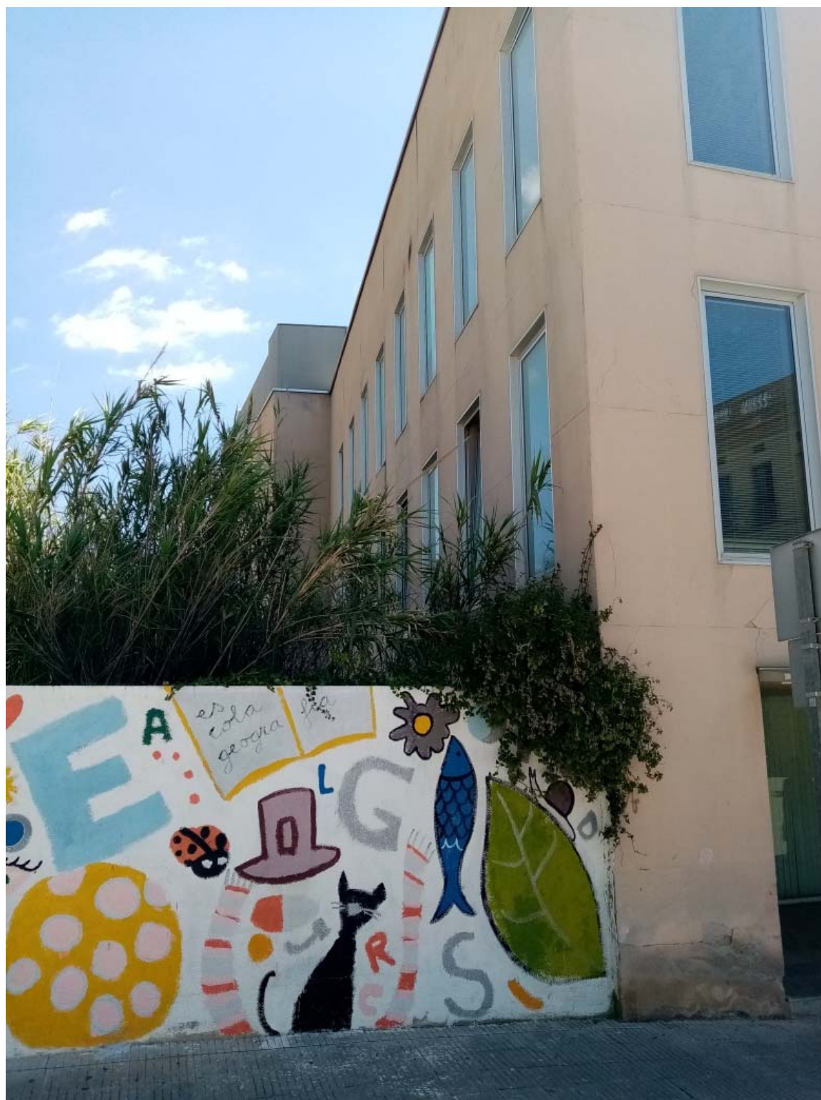
MJU-99602.5 - Jutjats Arenys de Mar _ Façana Lateral Nord - Oest
