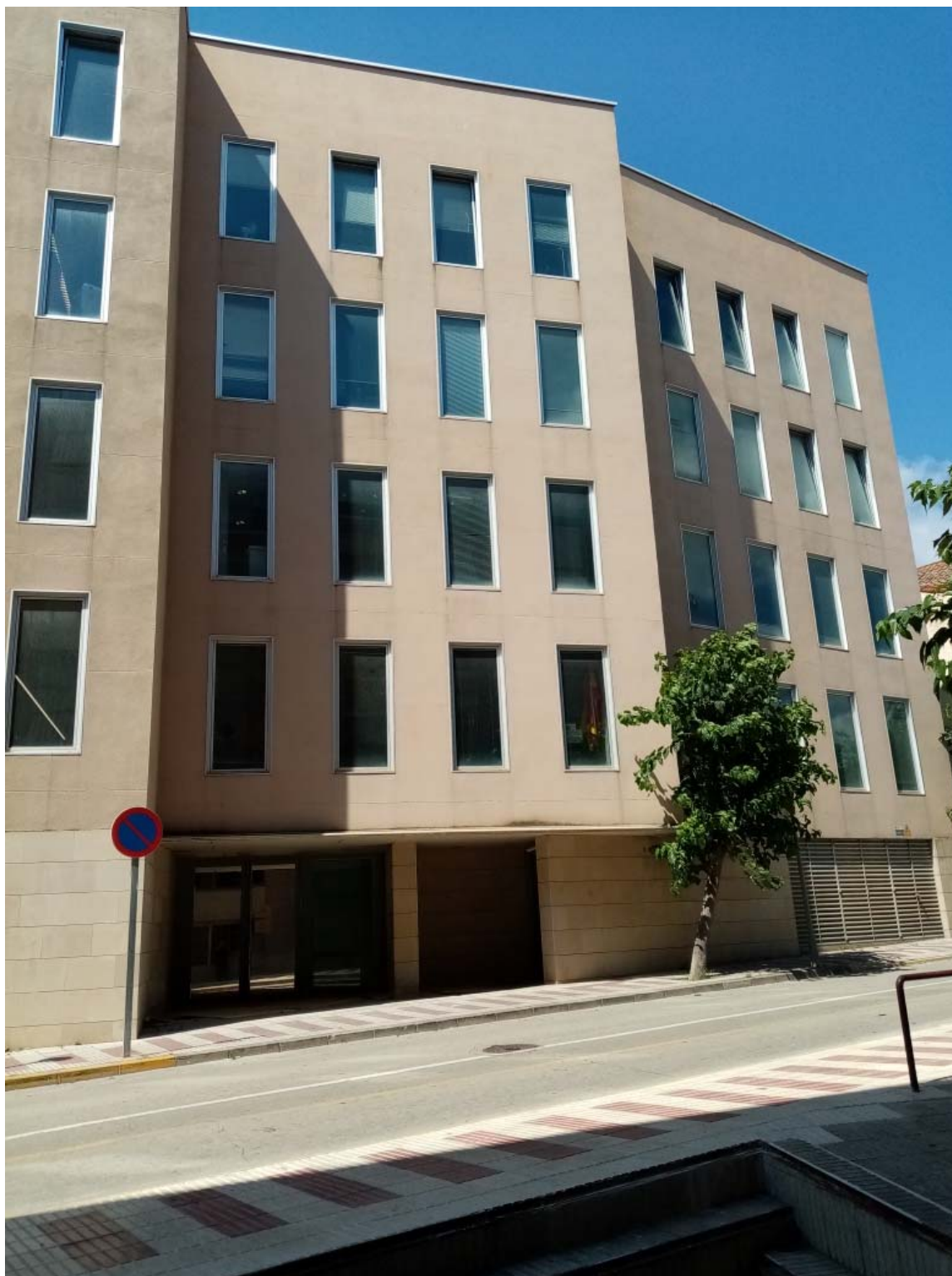
MJU-99602.5 - Jutjats Arenys de Mar _ Façana Guàrdia
