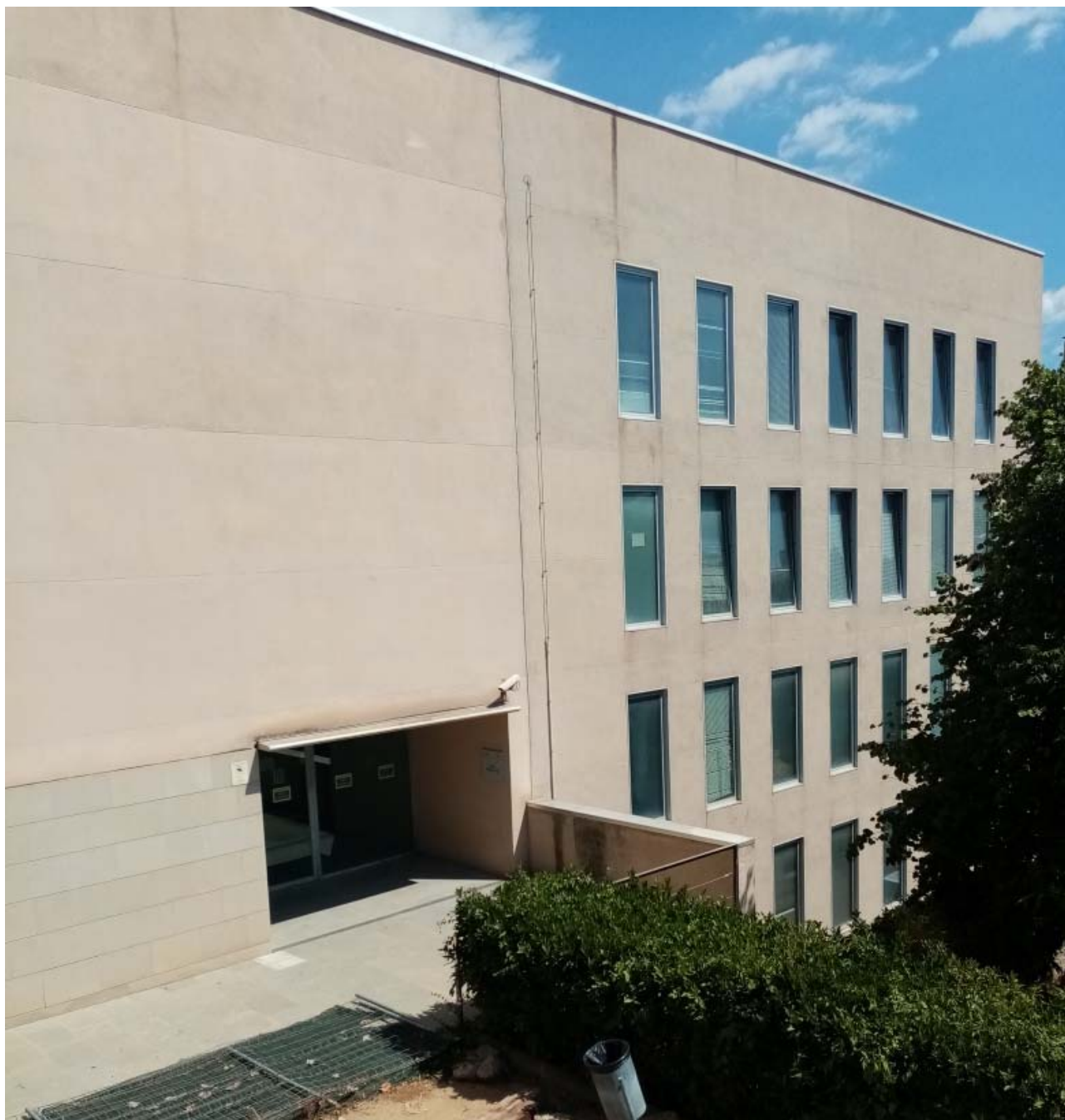
MJU-99602.5 - Jutjats Arenys de Mar _ Façana Lateral Sud- Est
