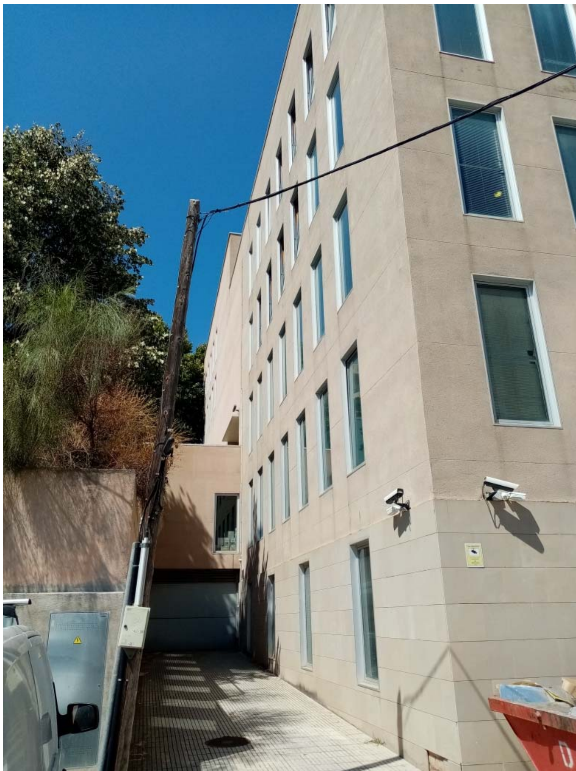
MJU-99602.5 - Jutjats Arenys de Mar _ Façana Lateral Sud- Est
