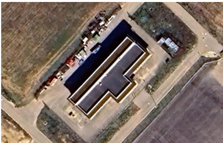
Figura 3 Cobertes objecte de projecte. Font: Infraestructures.cat
