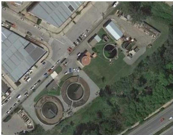
Figura 1. Vista aèria de l'EDAR Sant Celoni.
