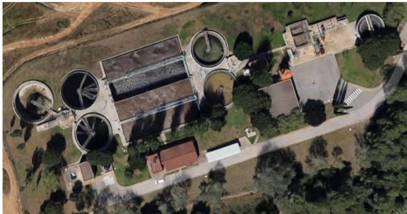
Figura 1. Vista aèria de l'EDAR Castellar
