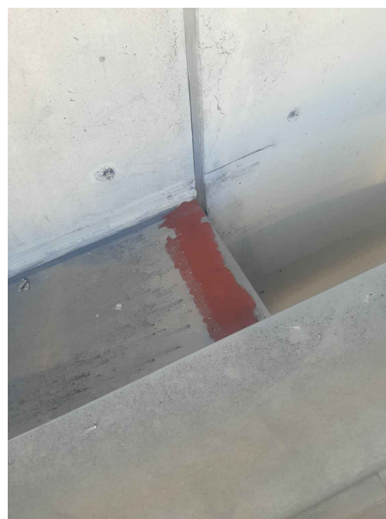
Fotografia 7. Imprimanció existent. A sanejar i refer.
