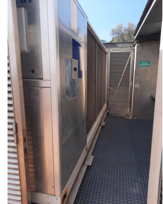
Imatge de plantes refredadores a substituir:
