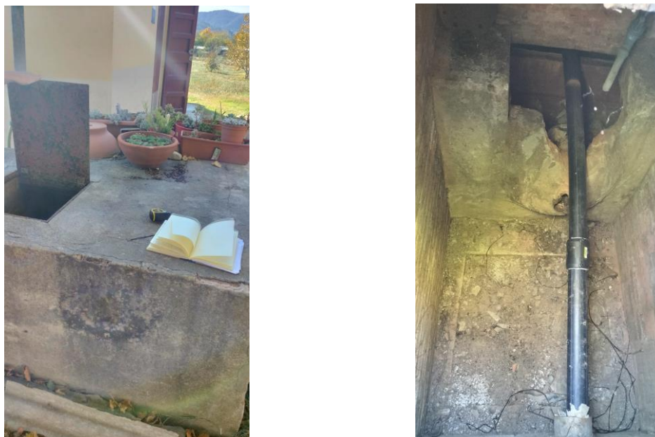
Estado actual arqueta exterior caseta pozo 5
