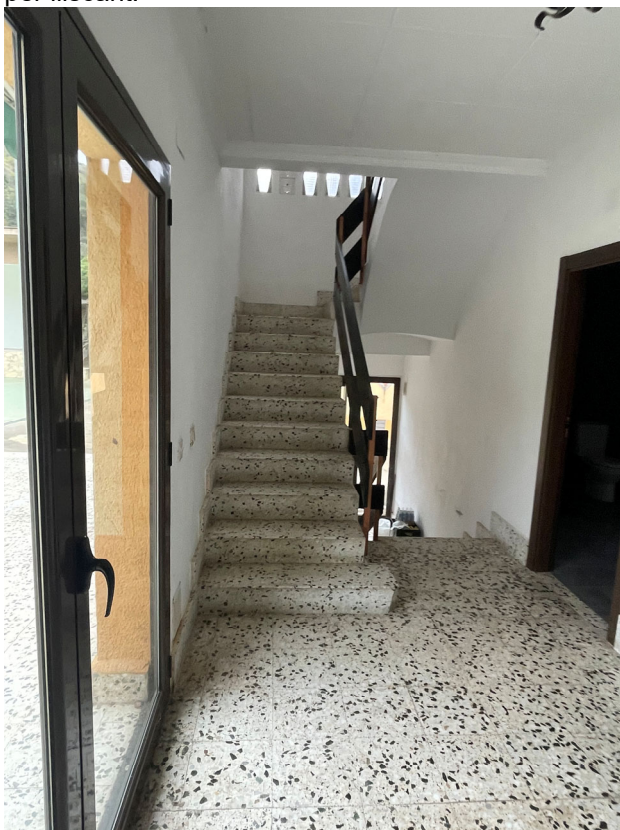
D.F.10. Planta baixa. Primer graó d'escala a tallar i porta de servei adaptat a la dreta a substituir per lliscant.
