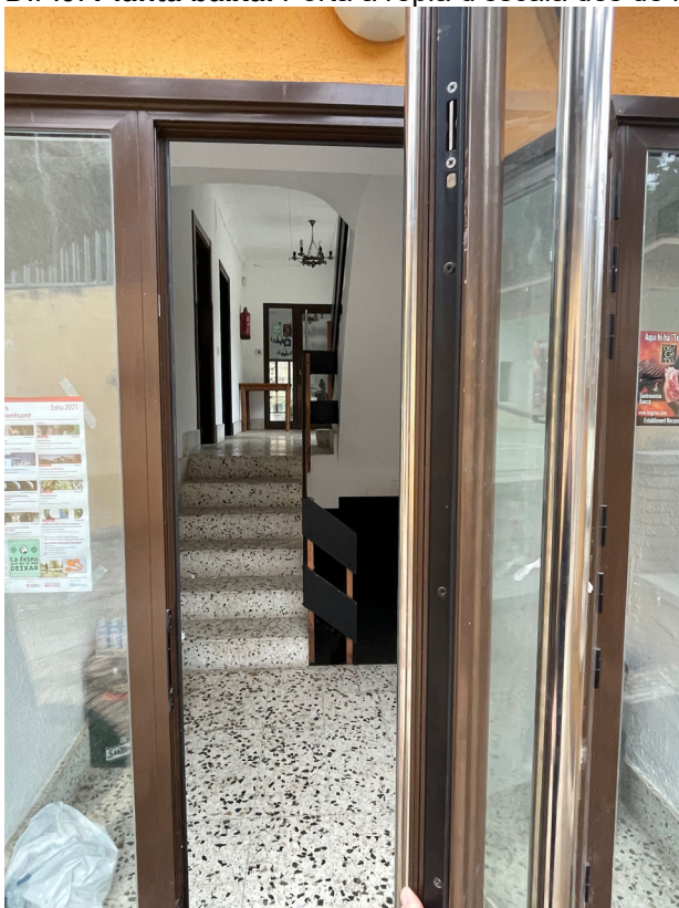
D.F.10. Planta baixa. Primer graó d'escala a tallar i porta de servei adaptat a la dreta a substituir per lliscant.
