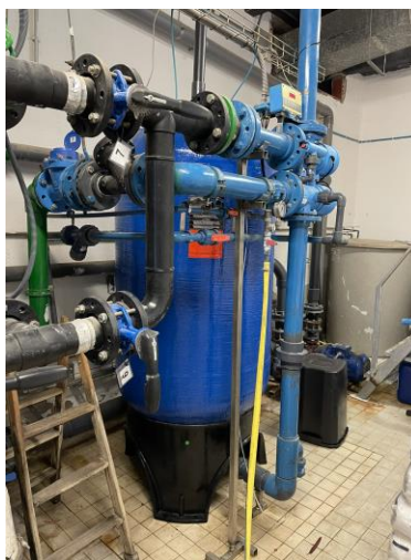
Imatge d'una de les parts del descalcificador, de la sala descalcificadors
