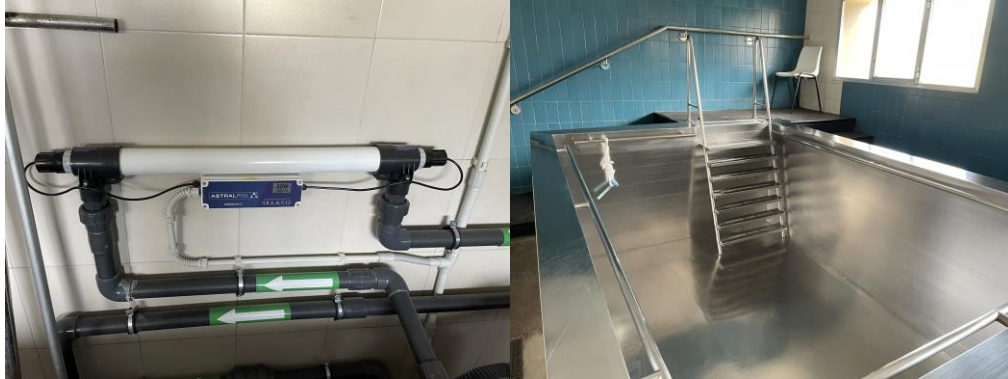
Imatge de la llampada d'UV i visió general del vas (buit en el moment de la fotografia)
