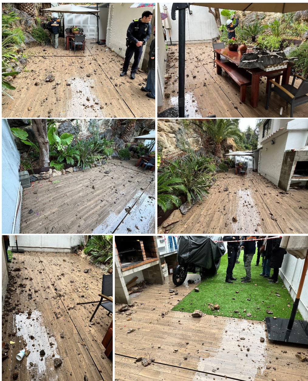
Figura 2: Acumulació de fragments despresos al pati de darrera de l'habitatge núm. 2bis, ICGC
