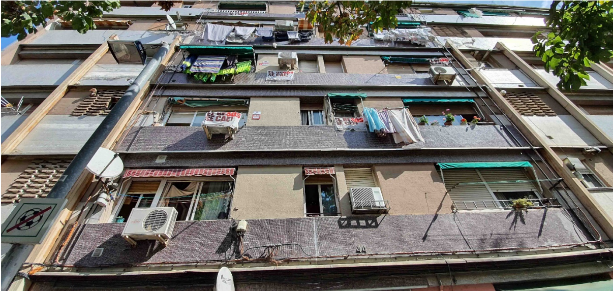
Imatge 20. Vista de consoles d'aire condicionat a façana al carrer d'Alfons el Magnànim.
