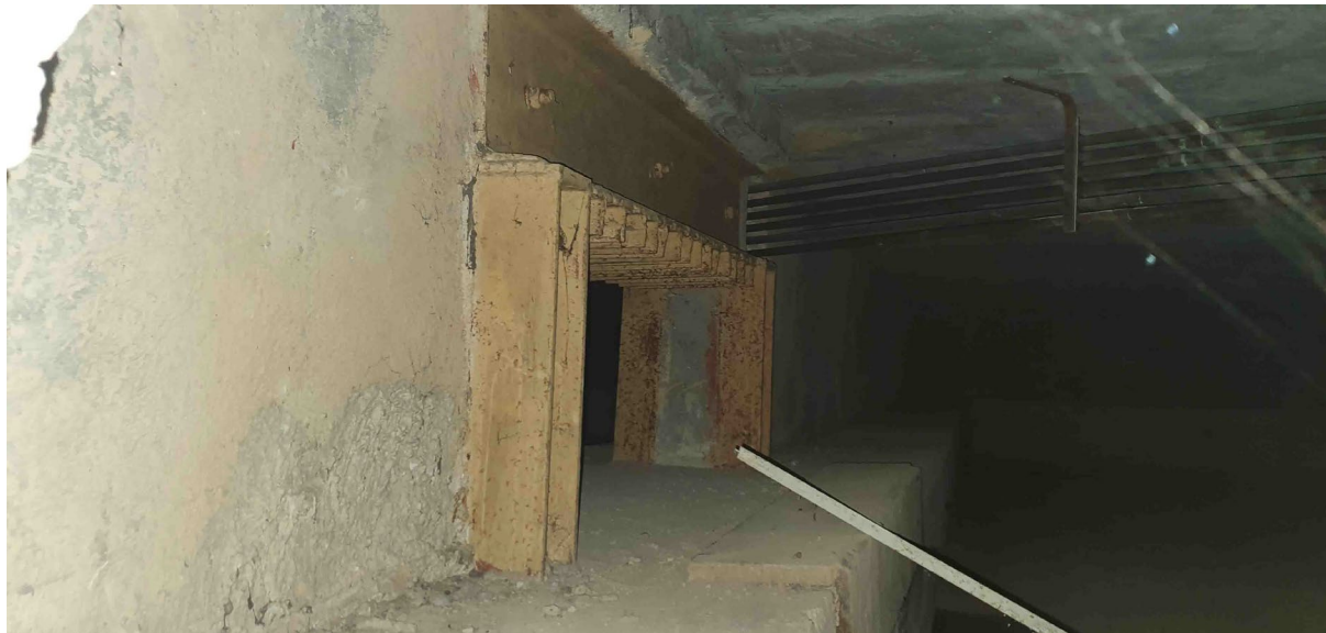
Imatge 5. Vista de cambra sanitària.
