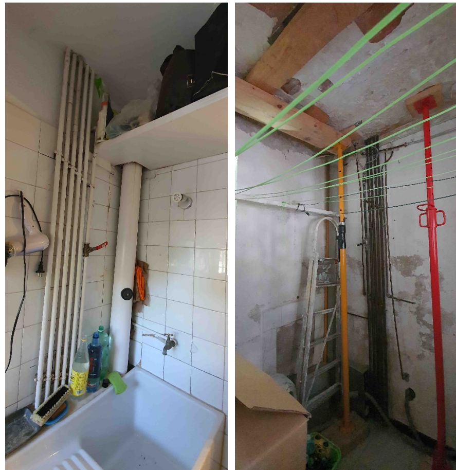
Imatges 15-16. Vistes de pentinat de tubs d'aigua a planta baixa i planta primera.
