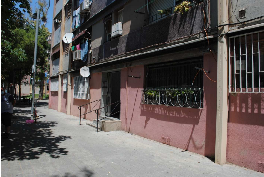
Imatge 7. Vista de Porta d'accés al vestíbul d'accés.
