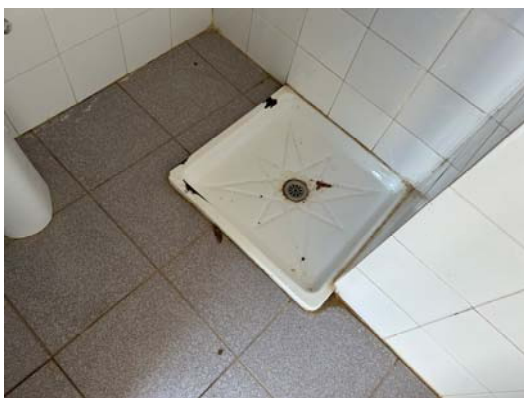
Visió interior del bany d'homes on s'observa un plat de dutxa que es preveu retirar.
