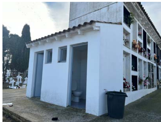
Visió de la façana principal i lateral dels banys existents per a homes i dones.
