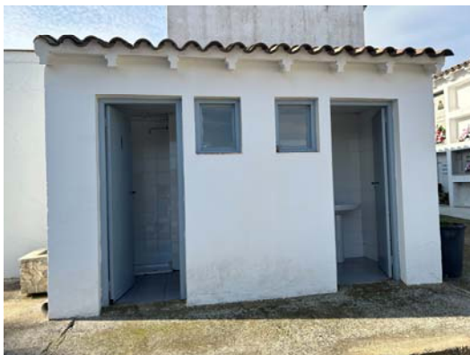
Visió de la façana principal dels banys existents per a homes i dones.
