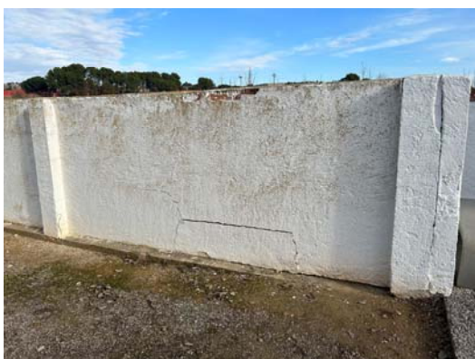
Visió de tram de mur objecte de reparació.
