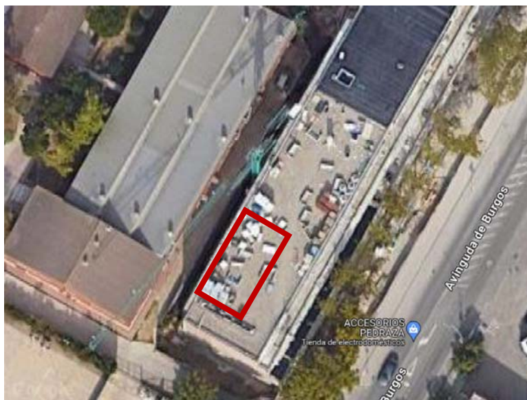
Figura 7 Zones d'abassegament de material fotovoltaic. Font: Infraestructures.cat
