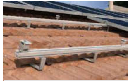
Detalle: Perfil solar-light
