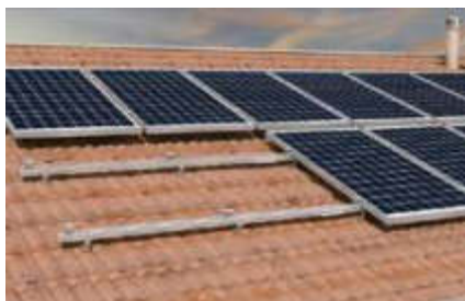
Cubierta coplanar
