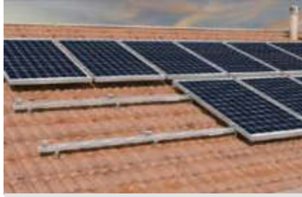
Cubierta coplanar
