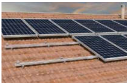
Cubierta coplanar con teja
