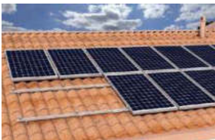
Cubierta coplanar con teja
