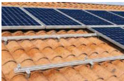
Cubierta coplanar con teja
