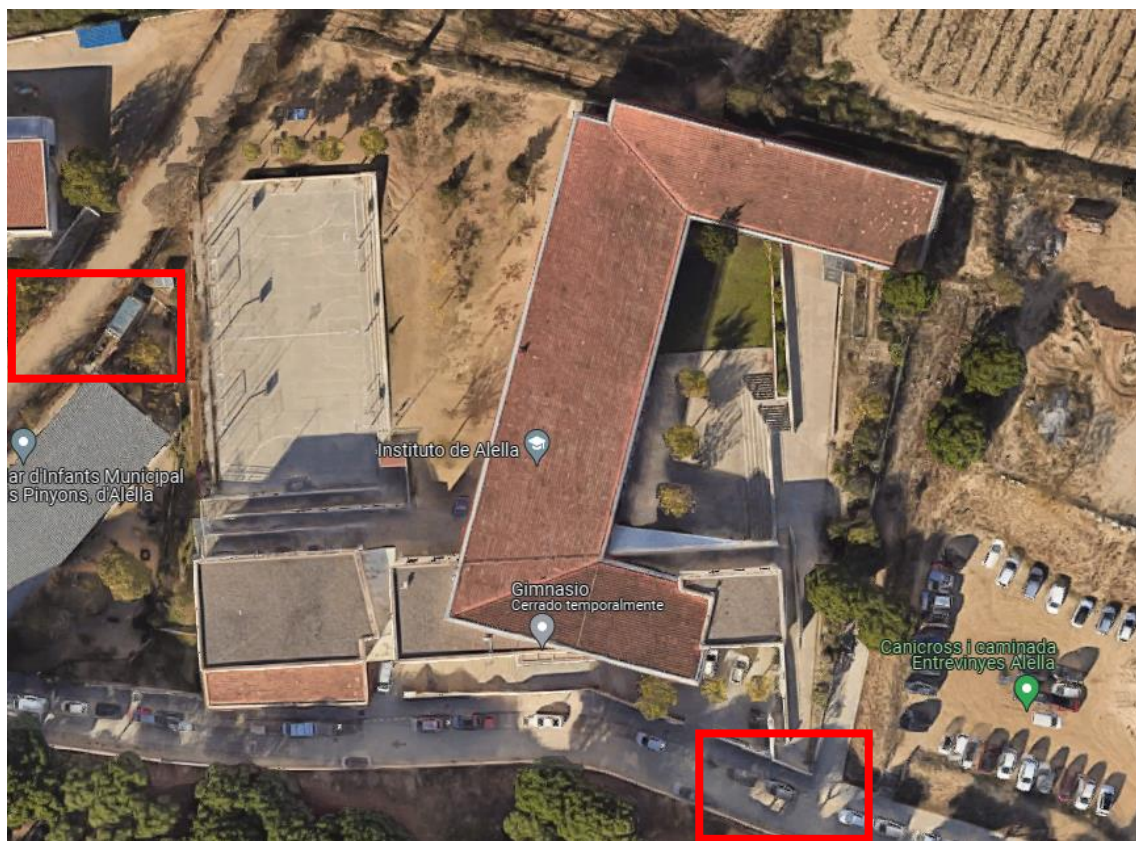
Figura 18 Accessos a edifici/parcel·la per a entrega de material. Font: Infraestructures.cat
