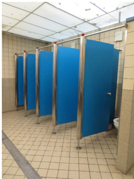
4. Mampares fenòliques i cel ras.
