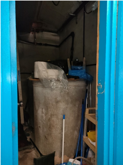
7. Sala dipòsits de fibrociment.
