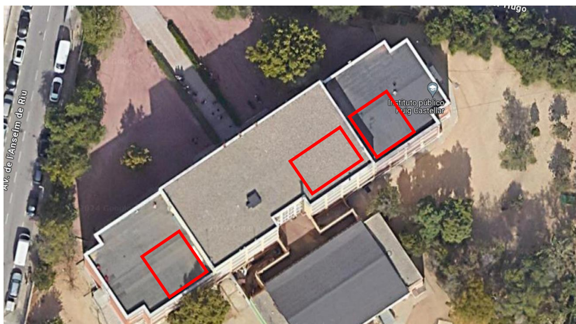
Figura 14 Zones d'abassegament de material fotovoltaic. Font: Infraestructures.cat
