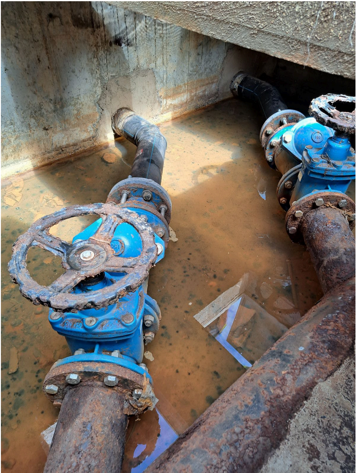
Foto Núm 5: Estat actual dels dos ramals DN150 del col·lector.
