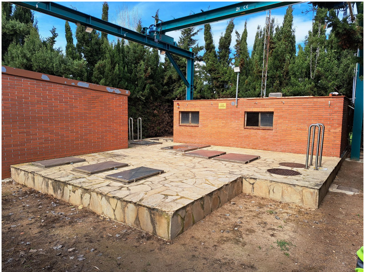
Foto Núm 1: Vista tapes accés al col·lector de l'EB la Mora.
