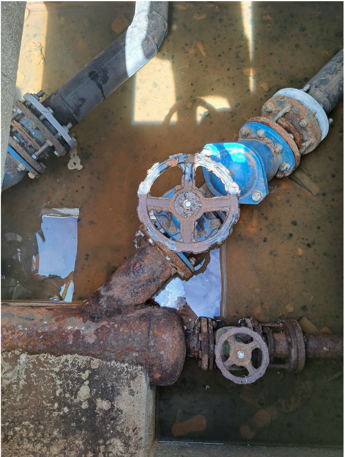
Foto Núm 7: Unió d'un dels ramals DN150 i el ramal DN80 al col·lector
