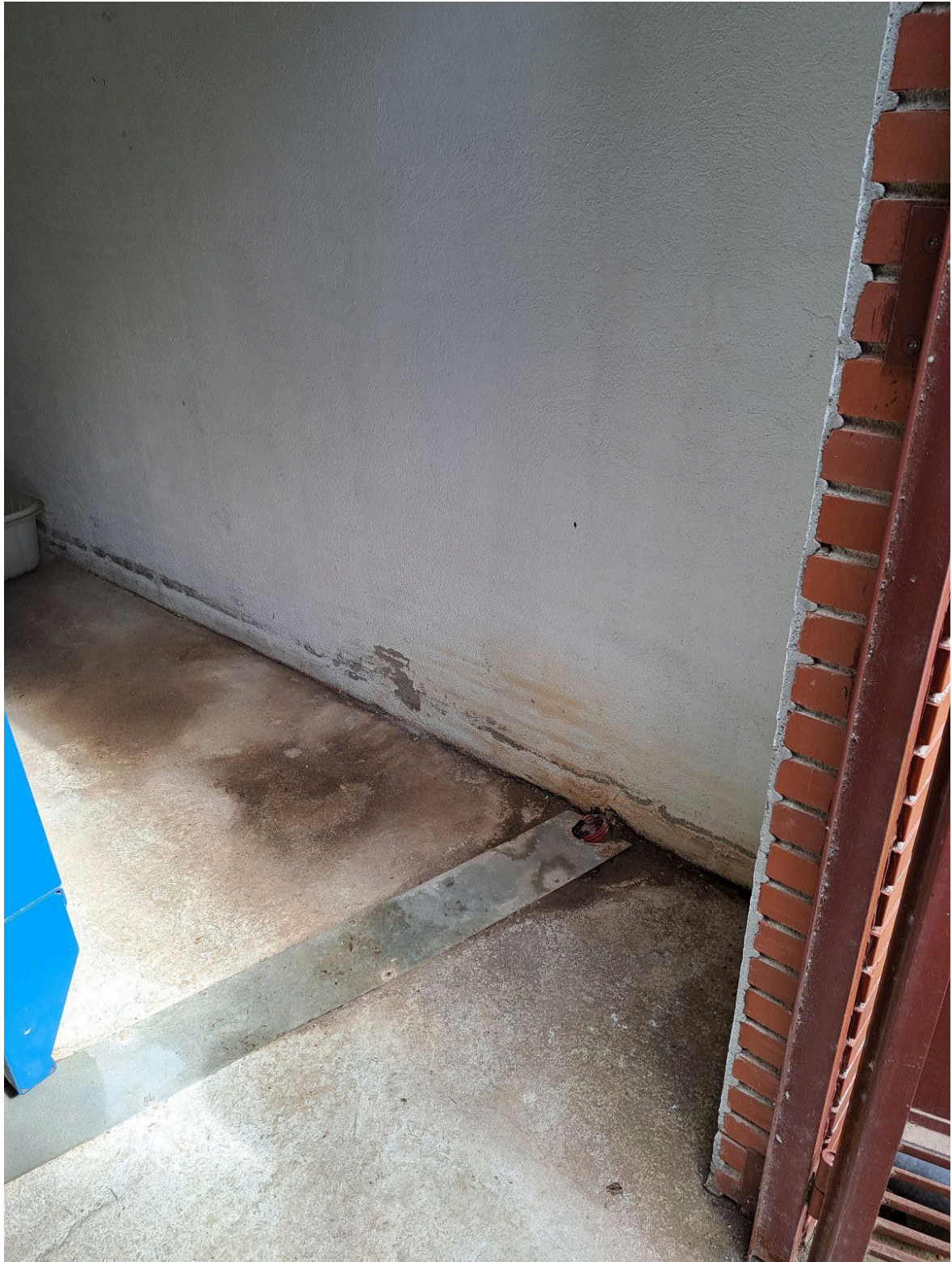
Foto Núm 2: Zona a picar per sanejament i connexió del nou col·lector.
