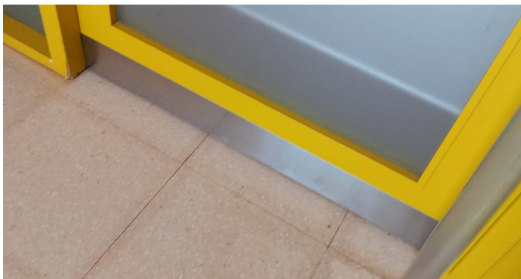
Fotografia 14: Detall acabat de les portes reparades
