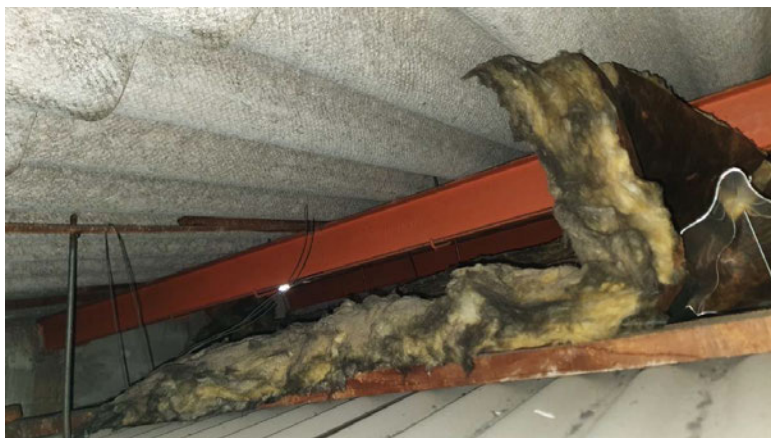
Interior del cel ras. Plaques asfàltiques ondulades i aïllament.
