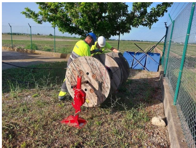
Imatge 2. Rul·los per al cable elèctric
