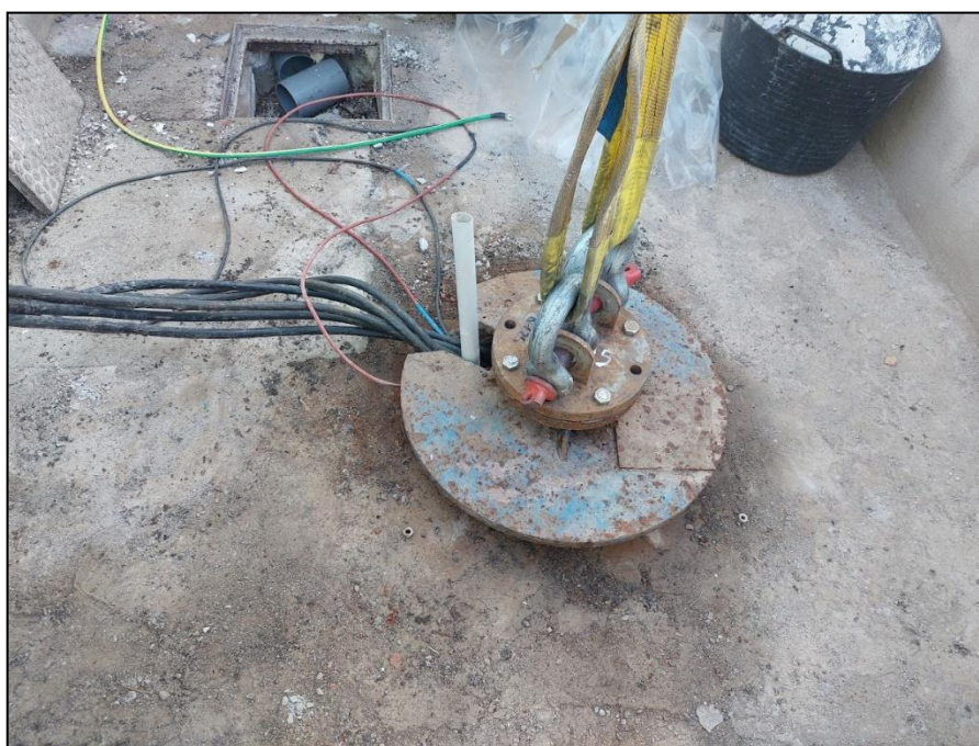
Imatge 3. Exemple de Brida amb ganxo per l'extracció del muntant.
