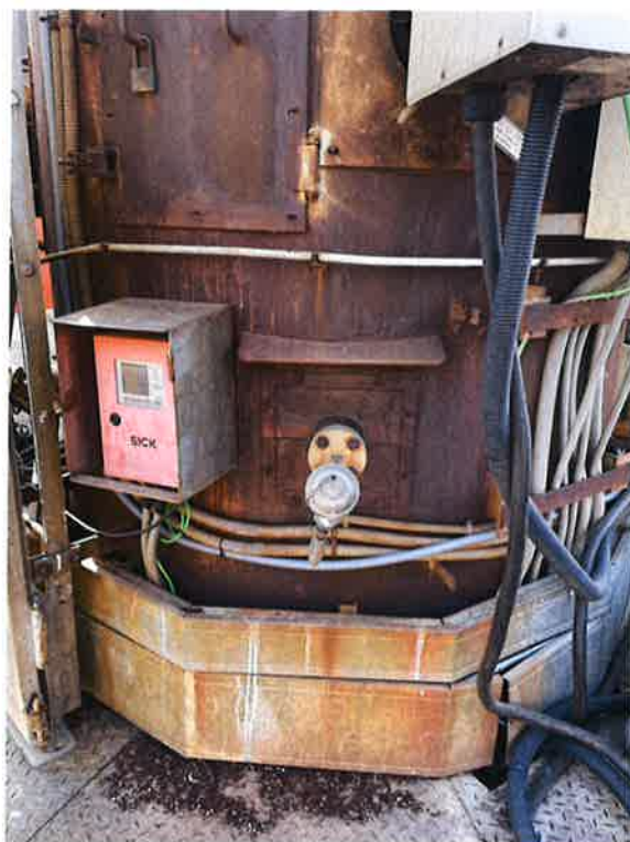
Imatge 6. Sensors de temperatura (L1, esquerra) i pressió (L2, dreta) actuals, que seran desplaçats per deixar un espai disponible per a la instal·lació dels sistemes d'extracció en continu de dioxines i furans.
