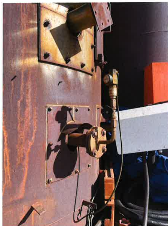
Imatge 6. Sensors de temperatura (L1, esquerra) i pressió (L2, dreta) actuals, que seran desplaçats per deixar un espai disponible per a la instal·lació dels sistemes d'extracció en continu de dioxines i furans.
