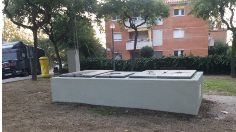
Captació Can Vilà
