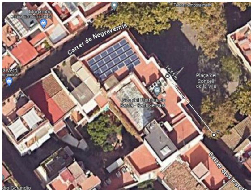
Detall màquines de clima a coberta i distància a la finestra més propera.
