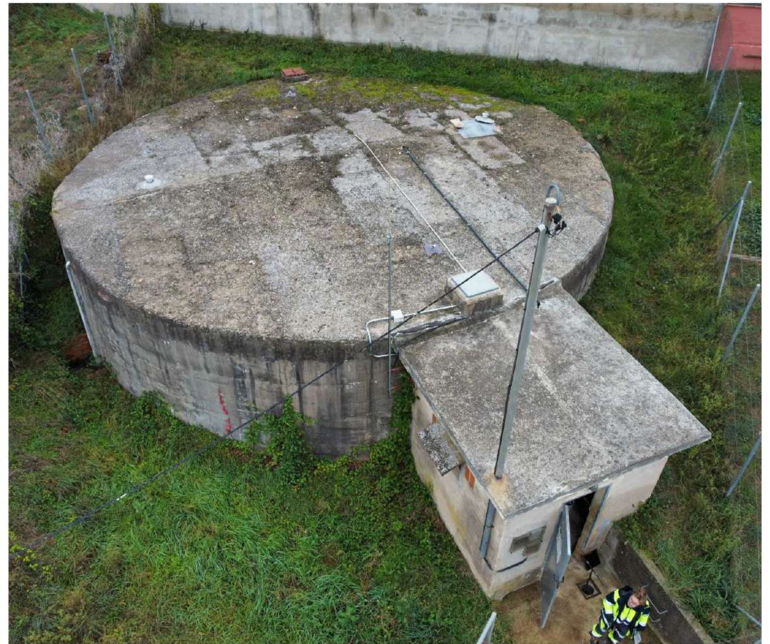
29. Estat actual de la coberta
