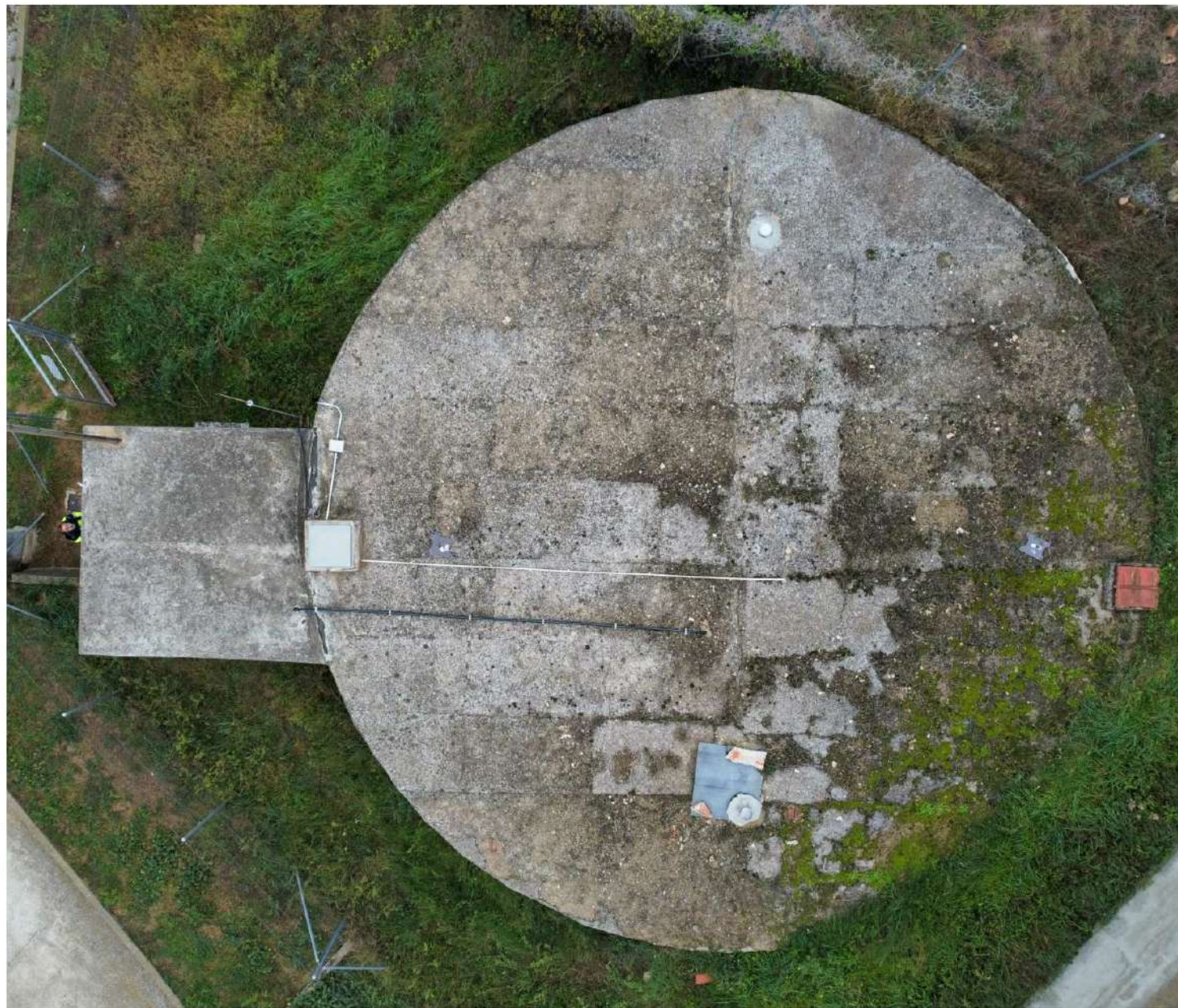
28. Estat actual de la coberta
