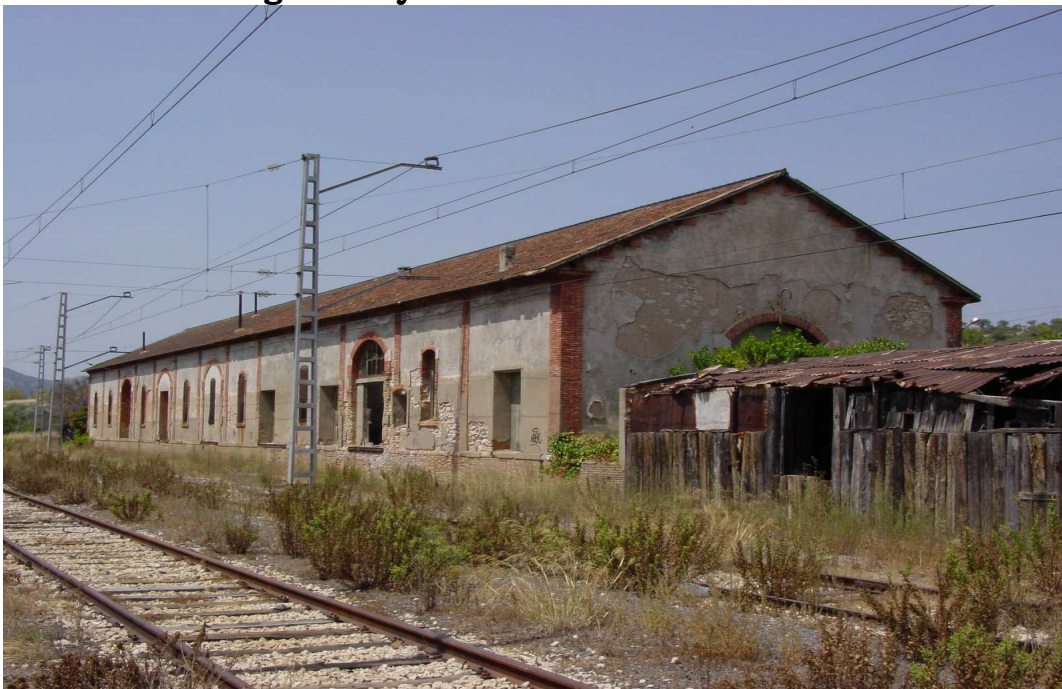
Estat actual del edifici any 2010
