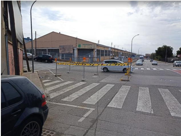
Foto 5. Situació de les tanques
