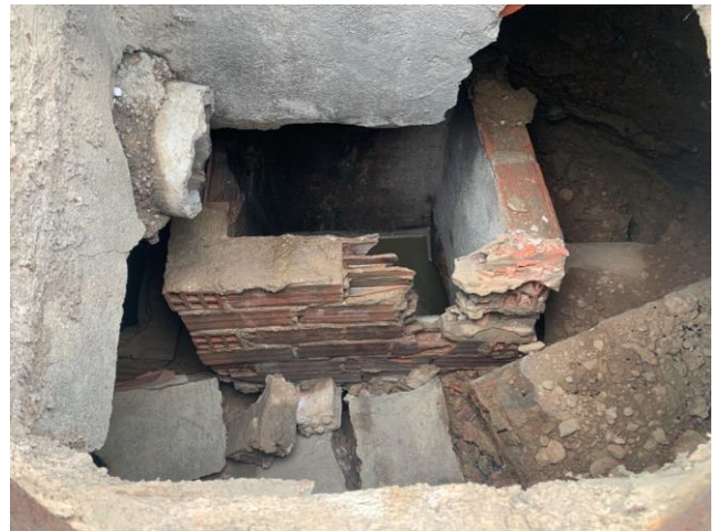
Foto 4. Cavitat generada pels diferents efluentes
