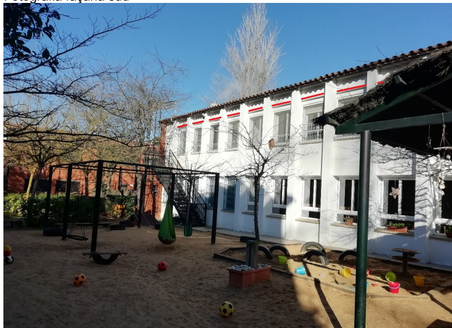
Estat actual Façana Est de l'Escola Bressol Mimosa
