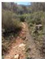
Sota Piscina Ordal 20240404_101217 (2).jpg
