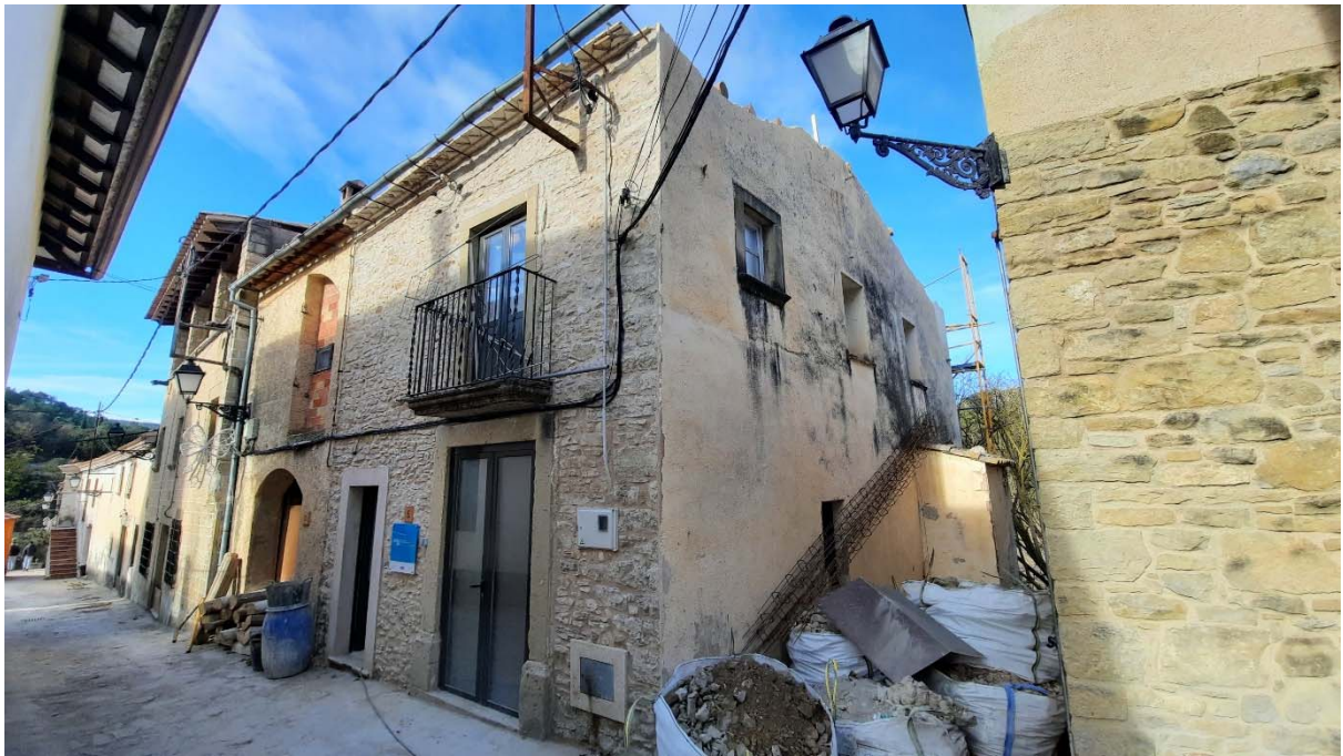
VISTA GENERAL DE LA CASA DEL POBLE – EXECUCIÓ OBRA FASE 0
