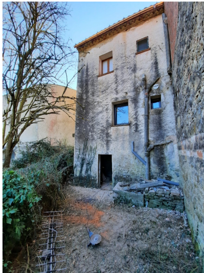
VISTA FAÇANA POSTERIOR CASA 6
