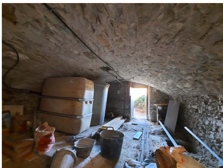
VISTA SEMISOTERRANI CASA 6 – EXECUCIÓ FASE 0
