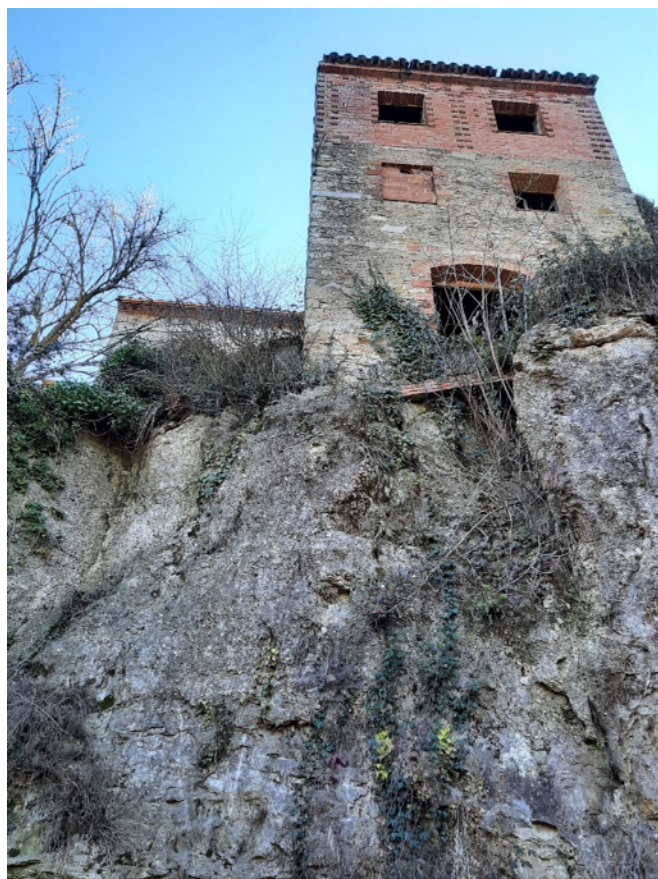
VISTA GENERAL DE LA FAÇANA POSTERIOR
