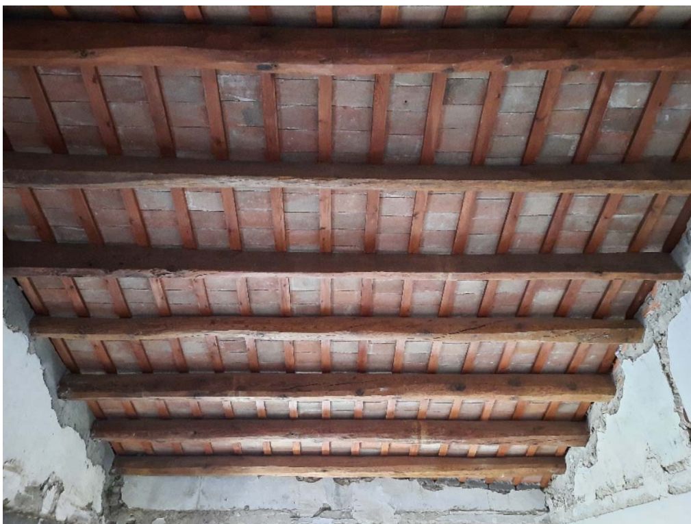
VISTA COBERTA REHABILITADA CASA 6
