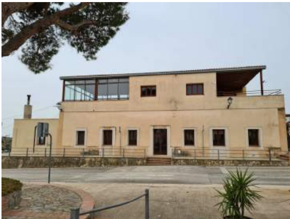
Façana carretera de la Vilella
