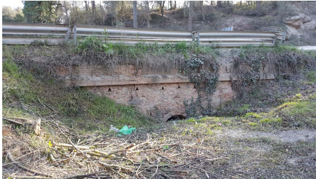
Pont després de les tasques d'esbrossada corresponents al projecte de pavimentació del camí de Montmany
