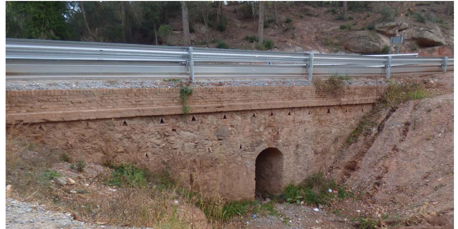
Pont després de la pavimentació del camí de Can Montmany
