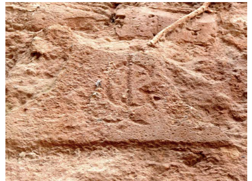
Restauració del Pont del Camí de ŠaŮc
