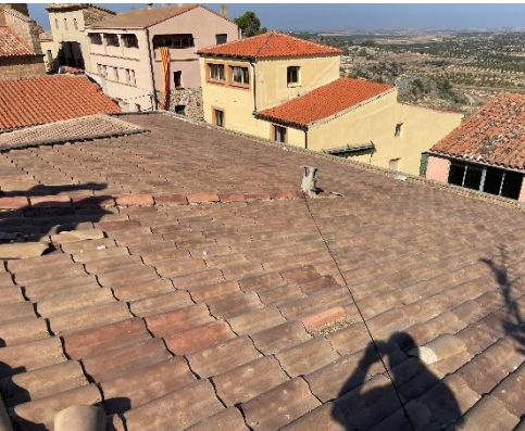
Imatge 07, 08 i 09: Elements de la coberta a enderrocar (teules, carener, xemeneies, lluernes...etc)
