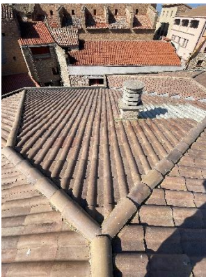
Imatge 07, 08 i 09: Elements de la coberta a enderrocar (teules, carener, xemeneies, lluernes...etc)
