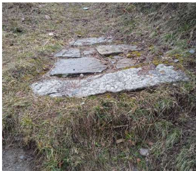
Imatge 3. Encatxat de pedra per a reforç puntual de camí existent.
