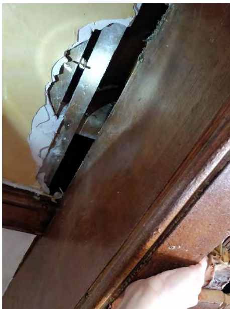
Fals sostre de guix sota bigues secundàries
