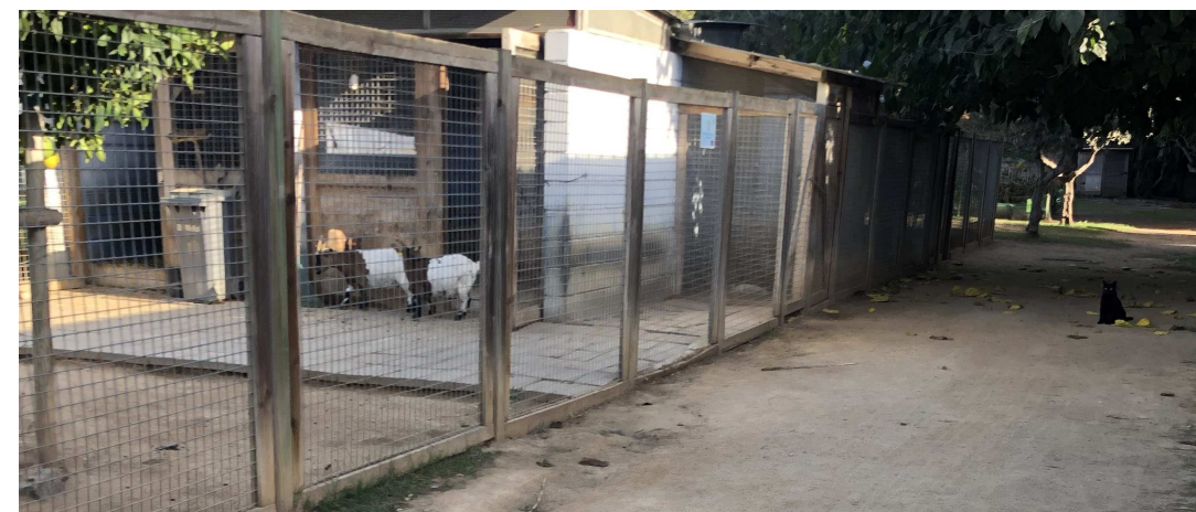
Detall tanca de fusta actual
