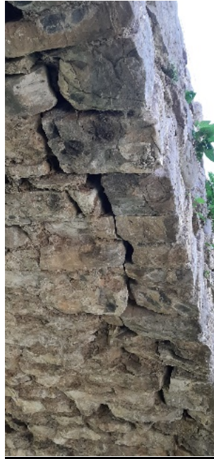
Esquerda longitudinal
