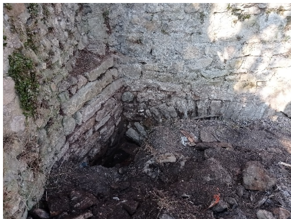
Vista parcial del tallamar i arc corresponent a l'arc de la volta de l'ull ocult
