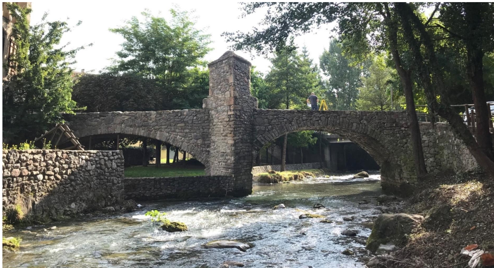
Vista aigües amunt. Arxiu SPAL
