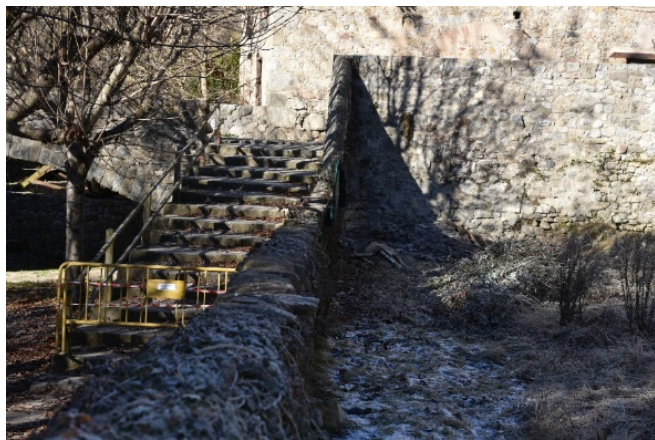
Escala i murs que amaguen una part del primer ull del pont, pilastra i tallamar entre el primer i segon ull
