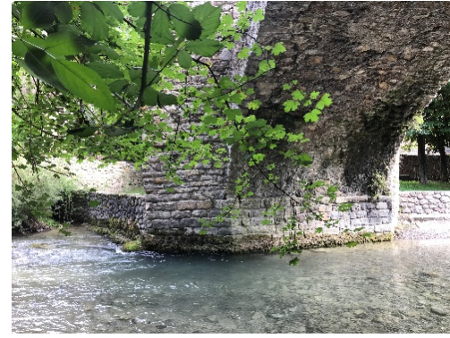
Intradós de la volta amb arrels
