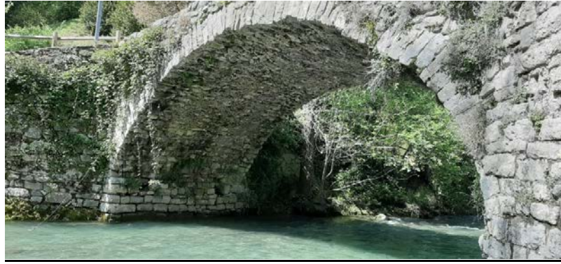
Volta i estrep del pont afectat per la vegetació
