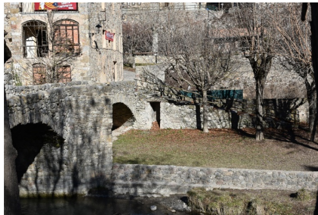
Mur longitudinal trancorre paral.lel al cabdal del riu
