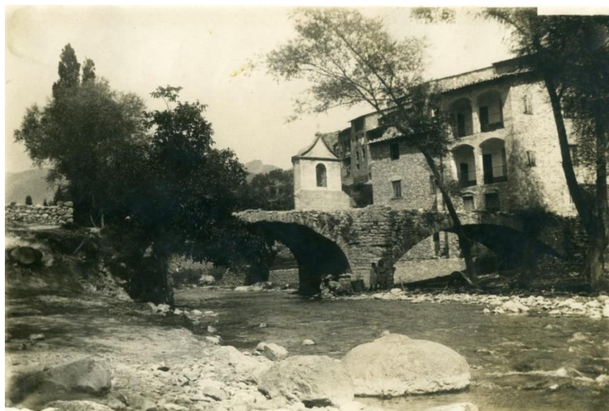
Bagà. Pont sobre el Bastareny. Vidal i Ventosa, 1925 ó 30 . Arxiu SPAL
