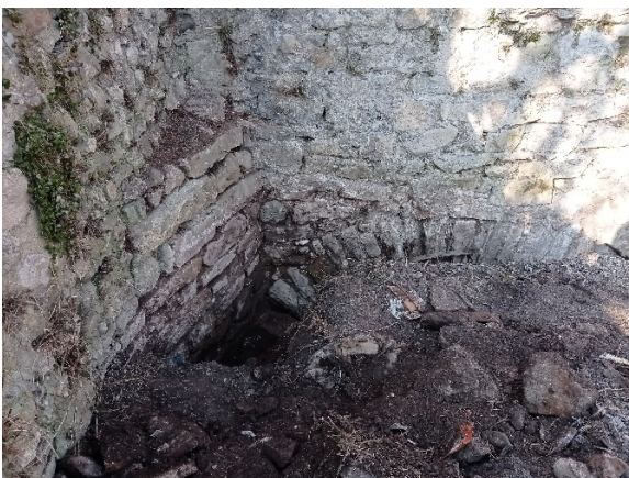
Tallamar i arc del ull ocult en els murs lateral i frontal
