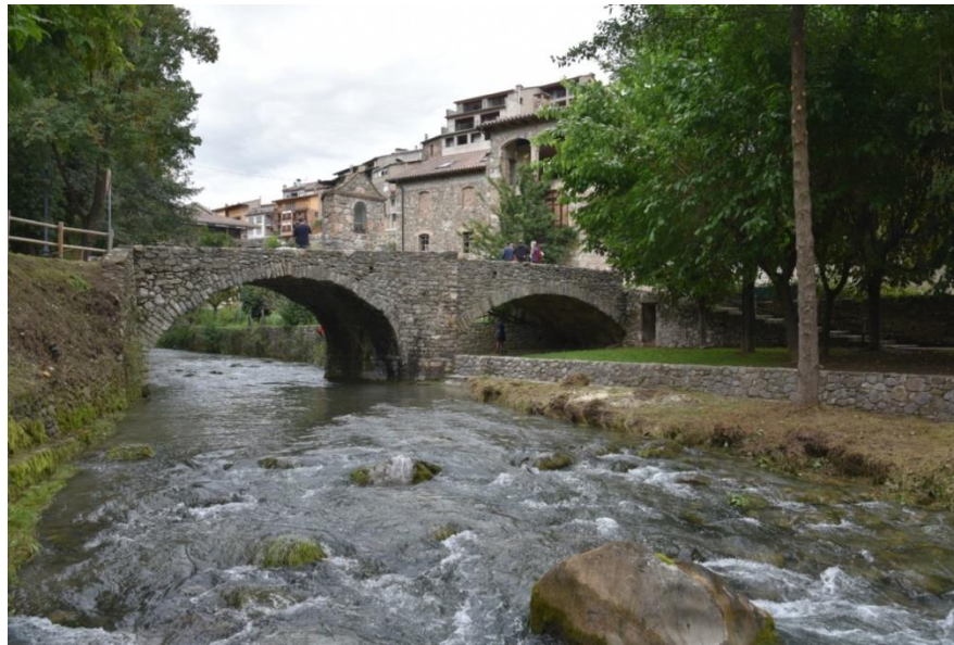
Vista general aigües avall del pont amb l'entron. Arxiu SPAL
