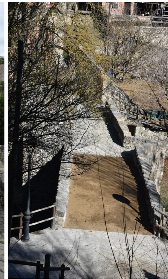
Estat actual del pont. Arxiu: SPAL
