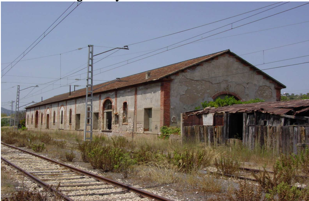
Estat actual del edifici any 2010
