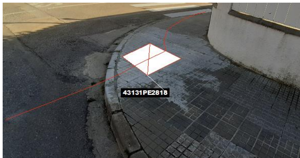
Fig 33. Nova microrasa del tipus 6c20 des del pericó en projecte 43131PE2818
