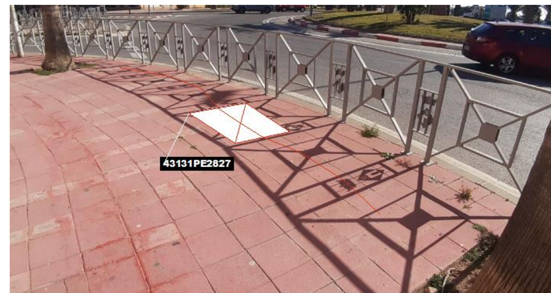
Fig 40. Nova microrasa del tipus 6c20 des del pericó en projecte 43131PE2827
