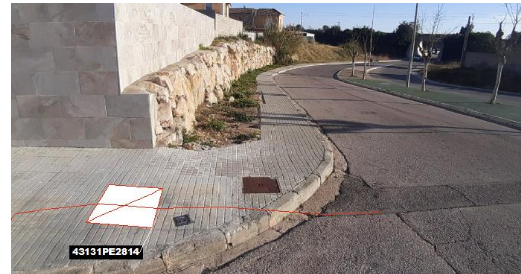
Fig 30. Nova microrasa del tipus 6c20 des del pericó en projecte 43131PE2814
