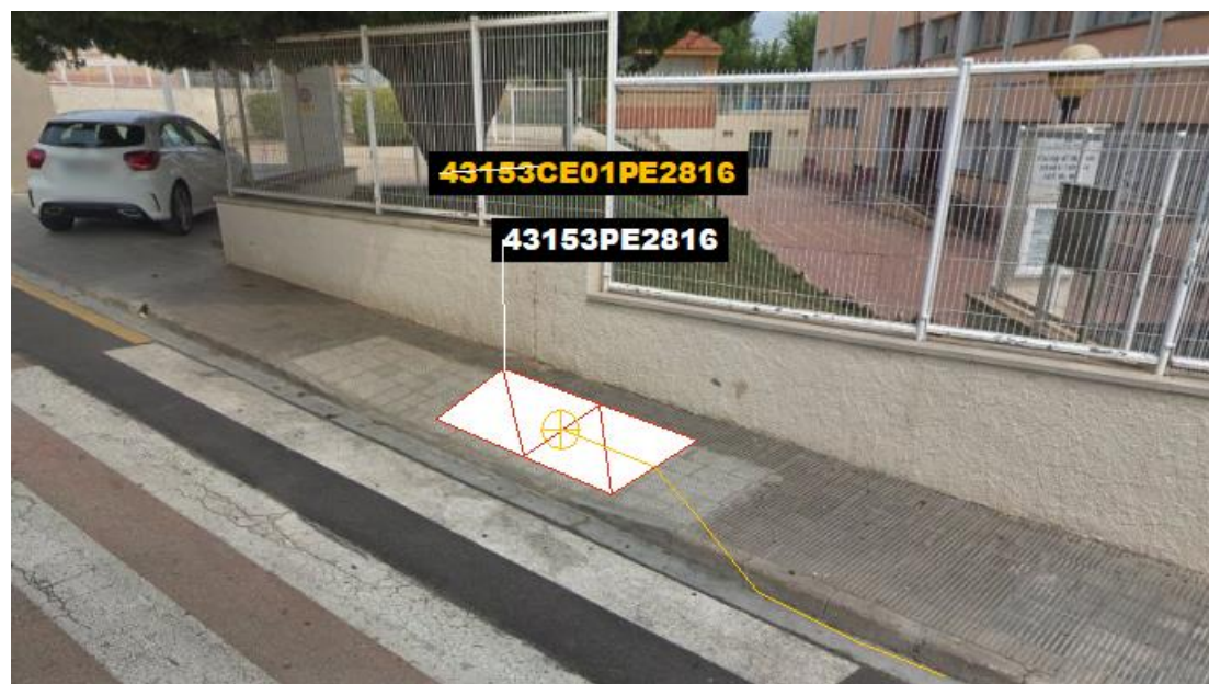
Fig 98. Instal·lació caixa d'empalmament 43153CE01PE2816.
