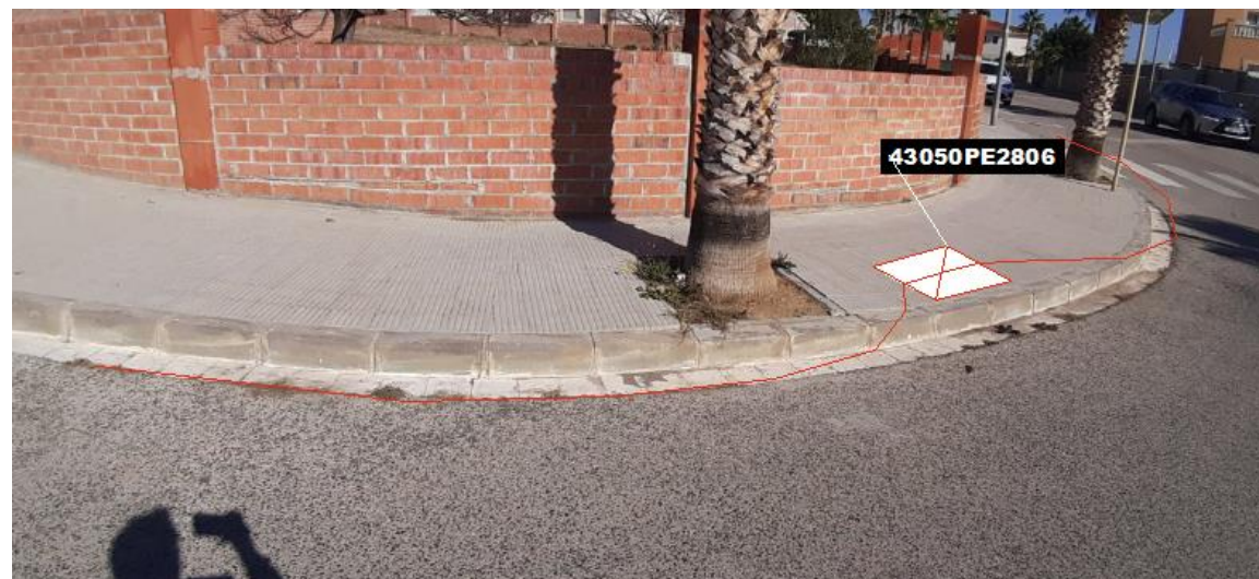
Fig 54. Nova microrasa del tipus 6c20 des del pericó en projecte 43050PE2806
