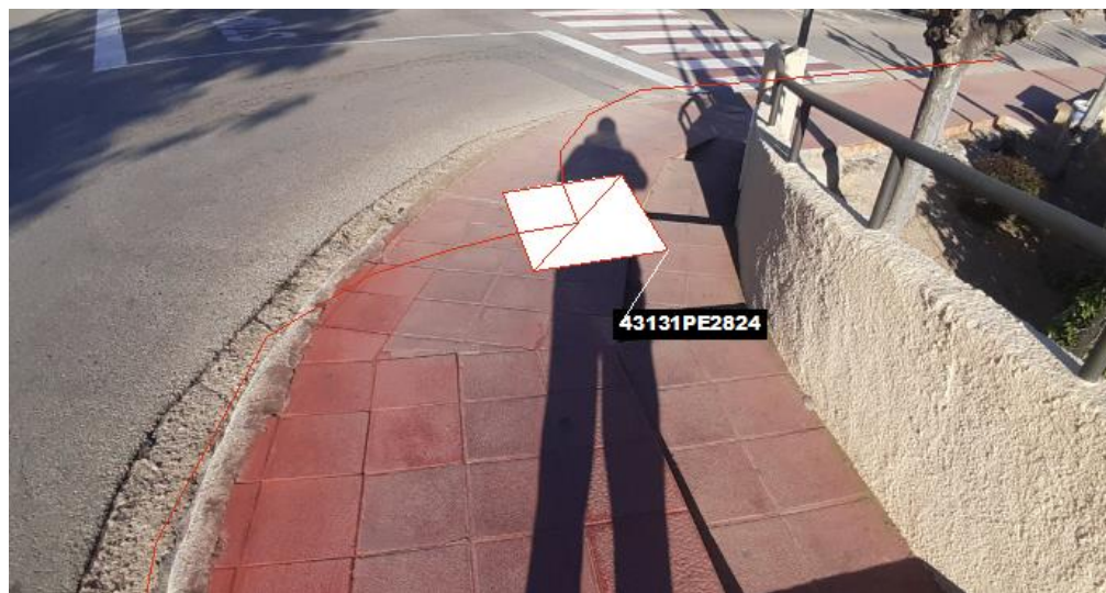
Fig 37. Nova microrasa del tipus 6c20 des del pericó en projecte 43131PE2824
