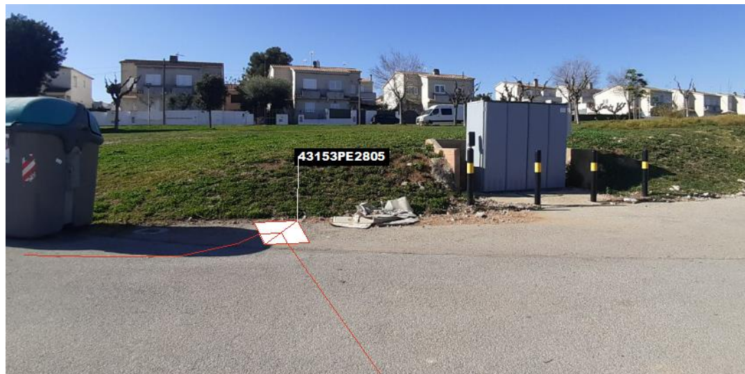
Fig 69. Nova microrasa del tipus 6c20 des del pericó en projecte 43153PE2805
