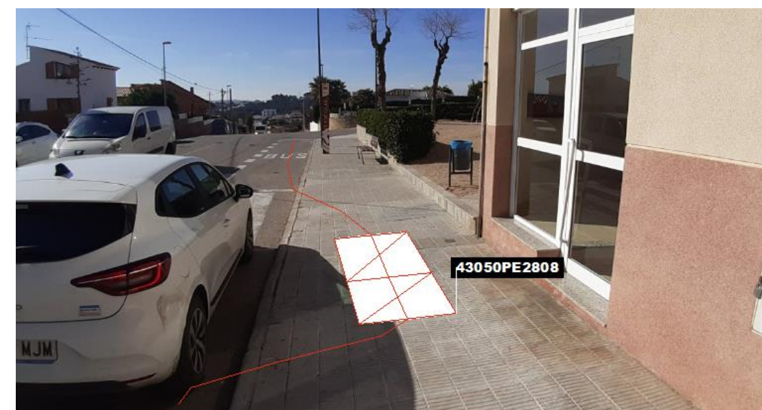
Fig 56. Nova microrasa del tipus 6c20 des del pericó en projecte 43050PE2808
