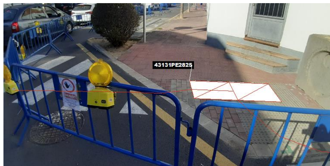
Fig 38. Nova microrasa del tipus 6c20 des del pericó en projecte 43131PE2825
