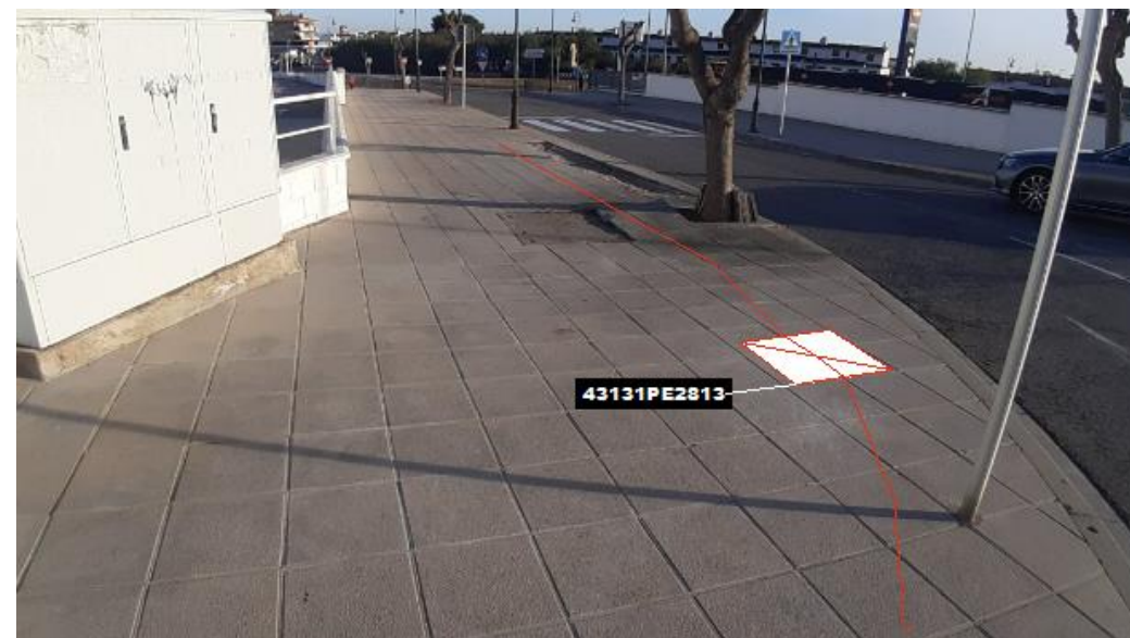
Fig 29. Nova microrasa del tipus 6c20 des del pericó en projecte 43131PE2813
