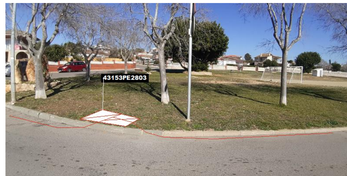
Fig 67. Nova microrasa del tipus 6c20 des del pericó en projecte 43153PE2803
