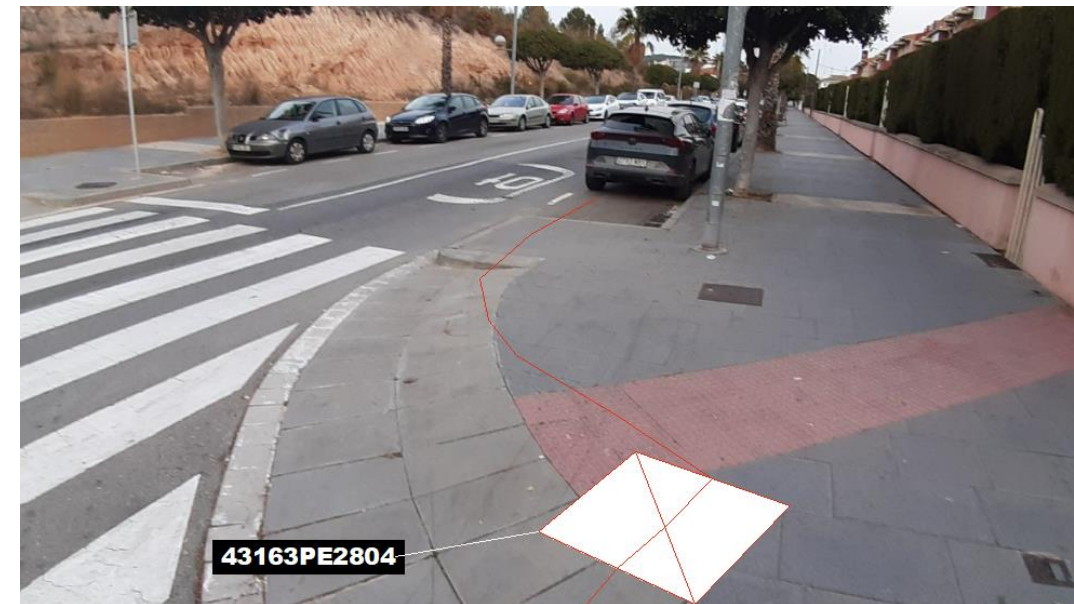
Fig 6. Nova microrasa del tipus 6c20 des del pericó en projecte 43163PE2804
