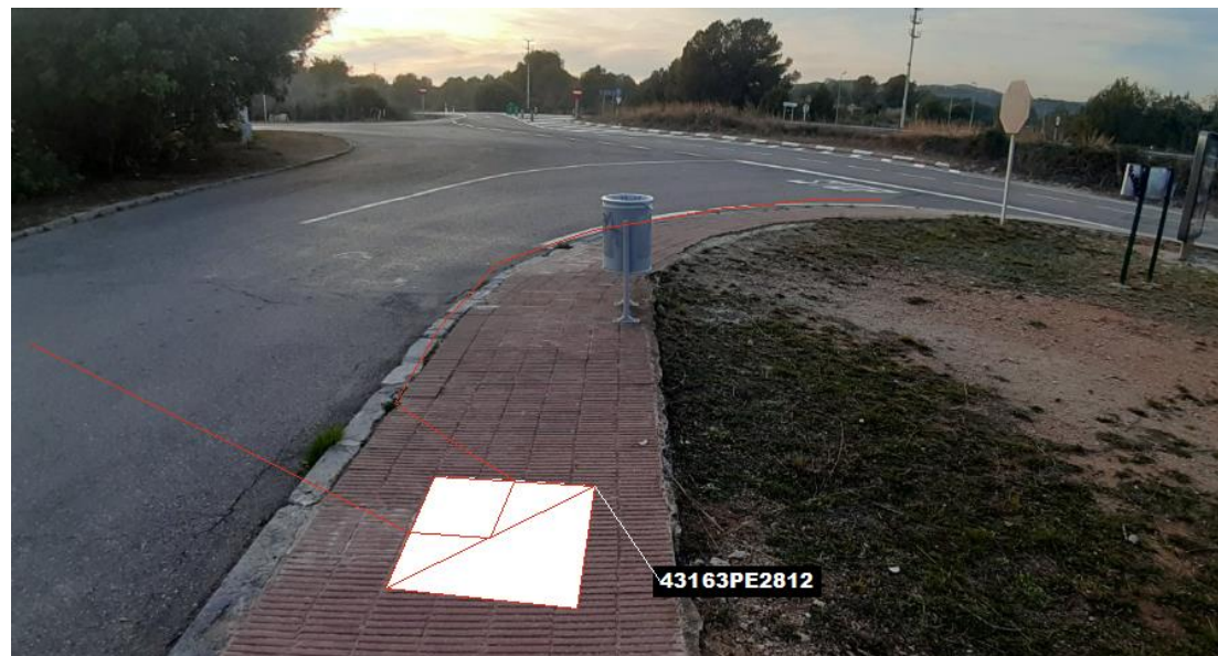
Fig 13. Nova microrasa del tipus 6c20 des del pericó en projecte 43163PE2812
