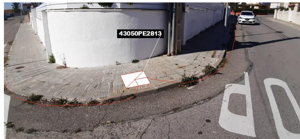
Fig 61. Nova microrasa del tipus 6c20 des del pericó en projecte 43050PE2813
