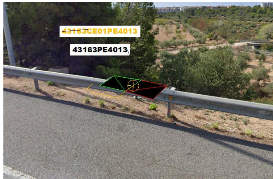
Fig 85. Instal·lació caixa d'empalmament 43163CE01PE4013.
