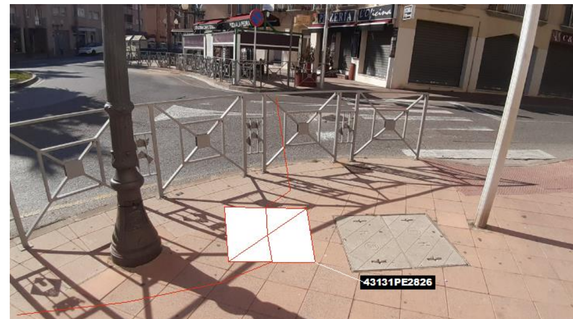
Fig 39. Nova microrasa del tipus 6c20 des del pericó en projecte 43131PE2826
