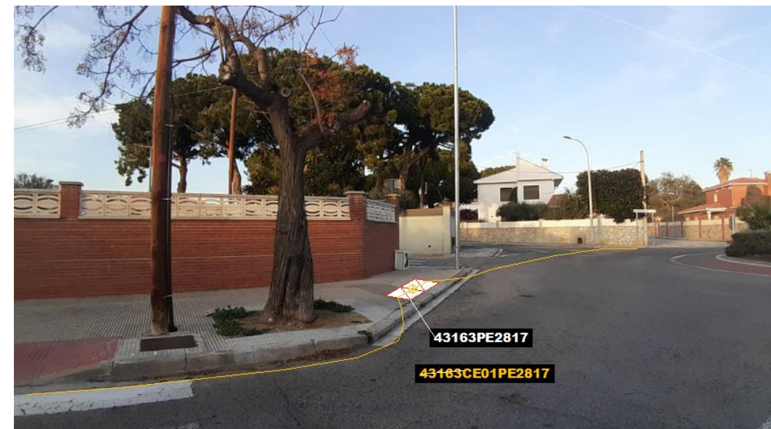
Fig 88. Instal·lació caixa d'empalmament 43163CE01PE2817.
