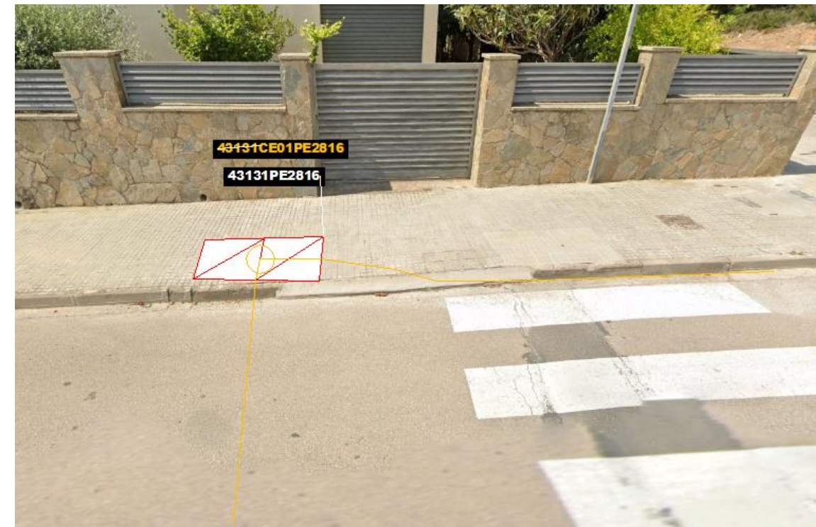
Fig 87. Instal·lació caixa d'empalmament 43131CE01PE2816.
