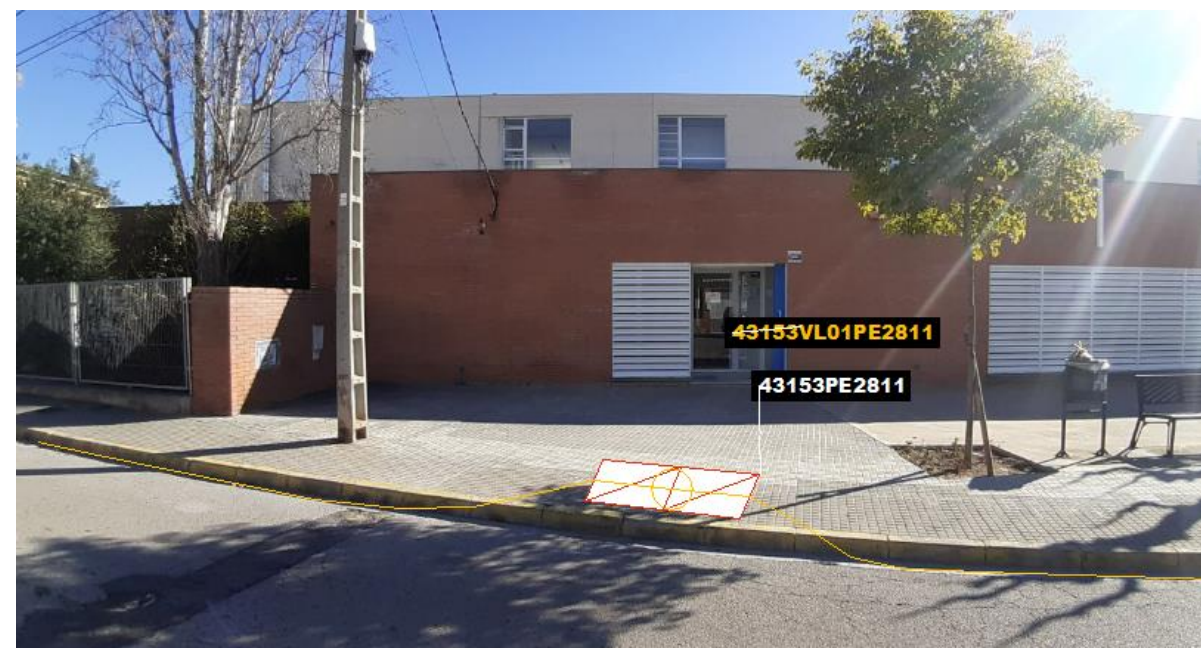
Fig 101. Instal·lació valona 43153VL01PE2811
