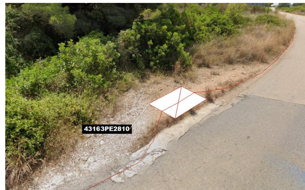
Fig 11. Nova microrasa del tipus 6c20 des del pericó en projecte 43163PE2810
