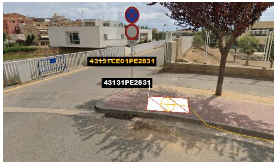
Fig 90. Instal·lació caixa d'empalmament 43131CE01PE2831.
