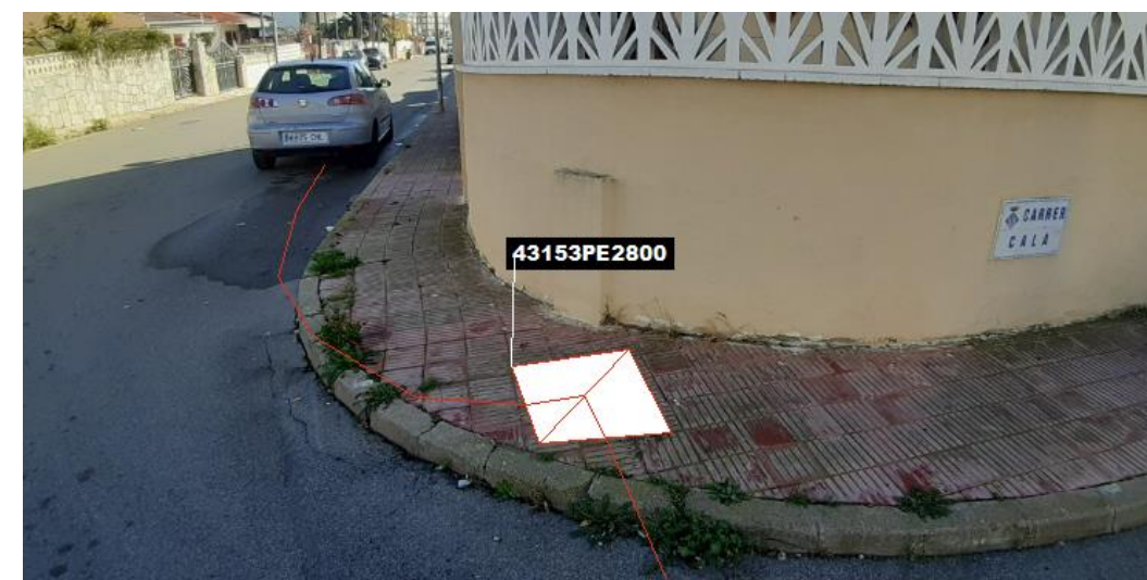
Fig 64. Nova microrasa del tipus 6c20 des del pericó en projecte 43153PE2800
