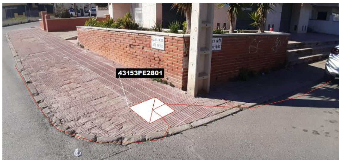
Fig 65. Nova microrasa del tipus 6c20 des del pericó en projecte 43153PE2801
