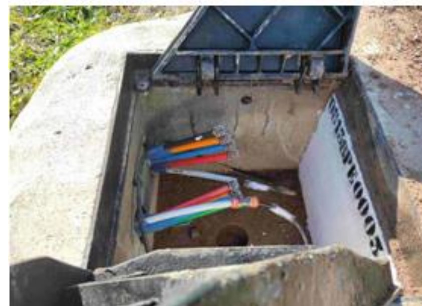
Exemple de tall dels microductes i taps d'obturació
