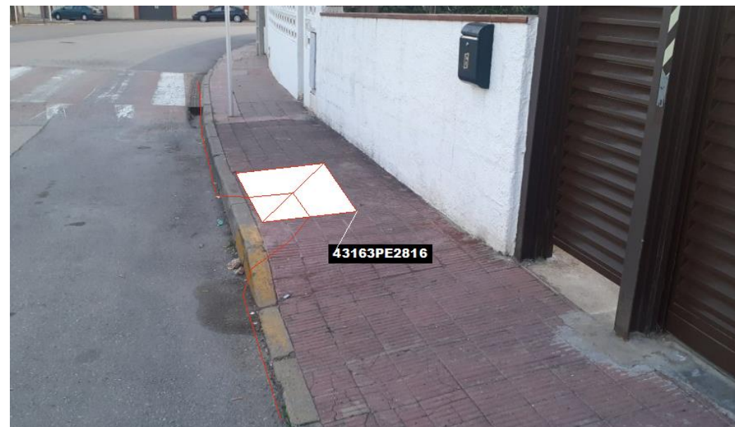
Fig 16. Nova microrasa del tipus 6c20 des del pericó en projecte 43163PE2816
