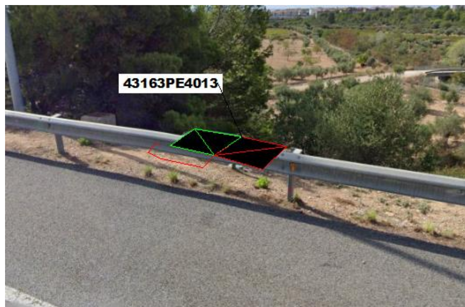
Fig 1. Nova canalització (6c20) des del pericó ja existent 43163PE4013. Ampliació de B2 a C2.
