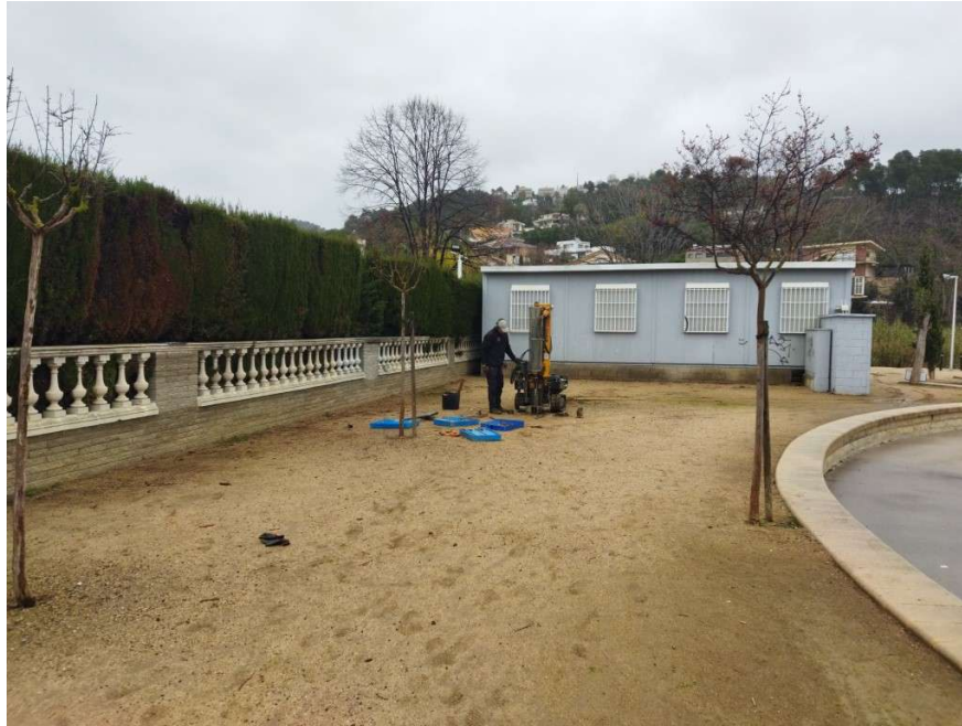
Realització del sondeig amb recuperació de testimoni continuu (S1).
