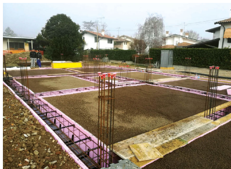
Imatge aïllament tèrmic fonamentació i base llosa.
