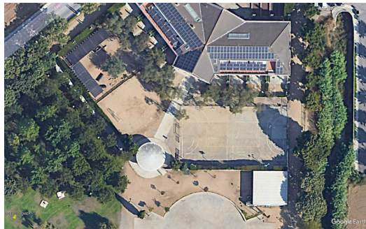
Imatge recinte escolar amb mòdul de menjador prefabricat existent. Font: STM
