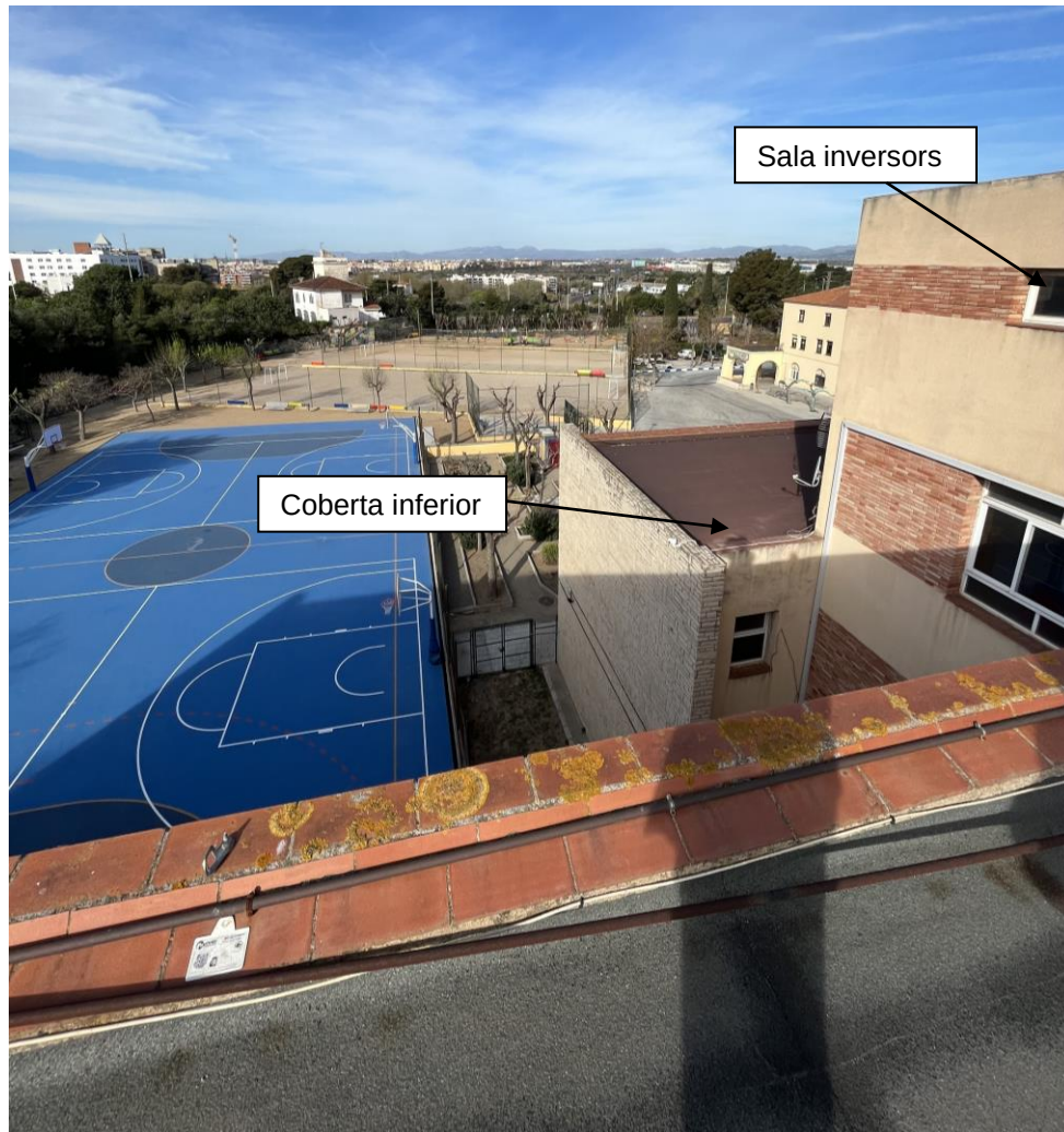
Ubicació coberta inferior i sala instal·lació inversors des de la coberta superior.
