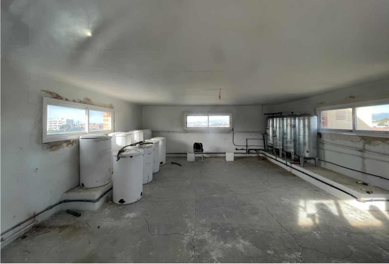
Sala on s'instal·laran els inversors, ubicada entre les dues cobertes.
