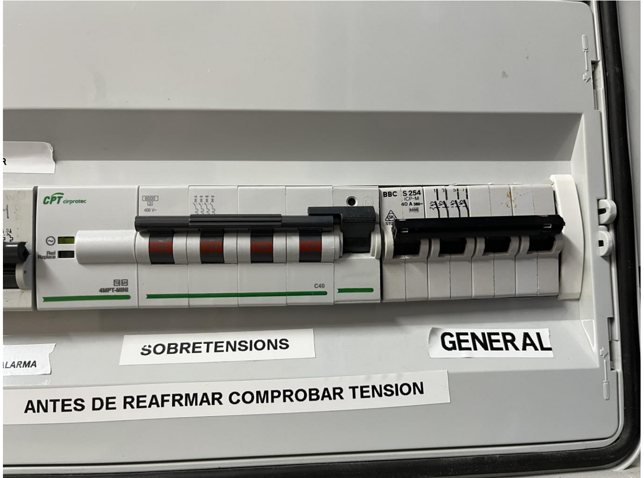
Detall imatge protecció quadre general edifici on es preveu instal·lar els captadors.
