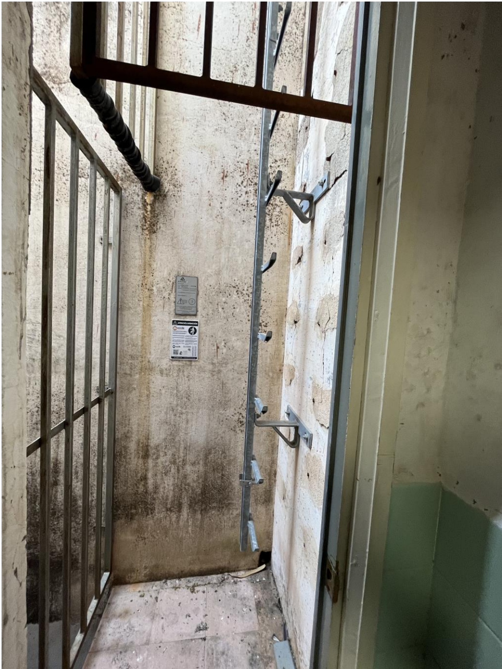
Escala interior edifici accés coberta superior.
