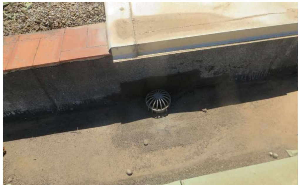
Fig. 5 i 6- Modificació de les buneres de la coberta.
