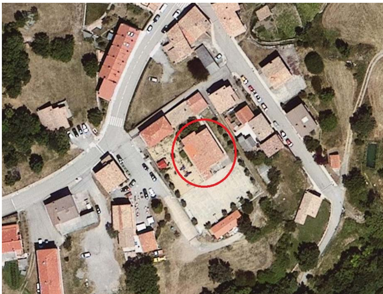
Imatge 02: Ortofotografia de l'ICGC de l'emplaçament de l'edifici de dependències auxiliars de l'escola que conté la Cuina i menjador, el gimnàs, l'aula de tecnologia i l'espai de llar d'infants actual.
