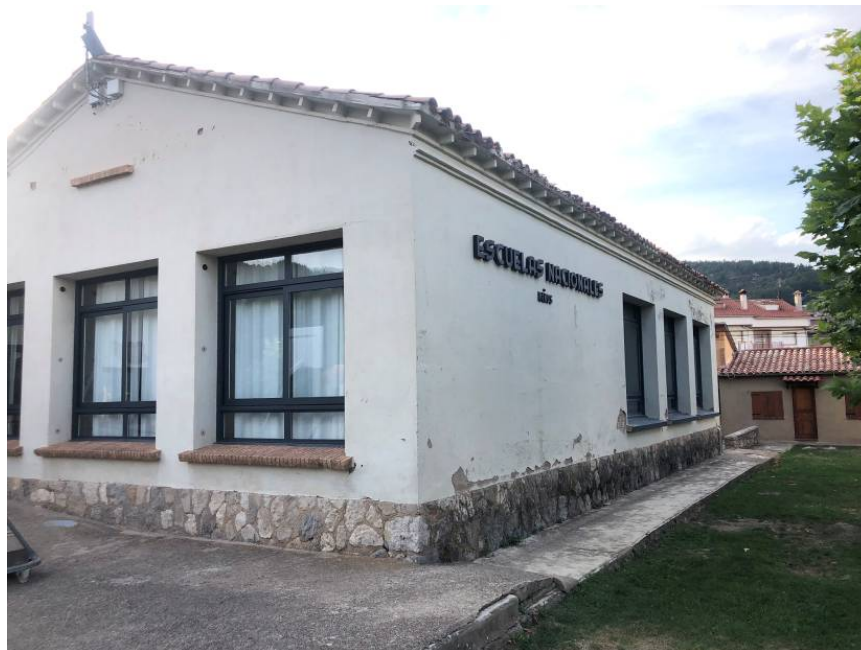
Imatge 03: Façanes sud-est i sud-oest.
