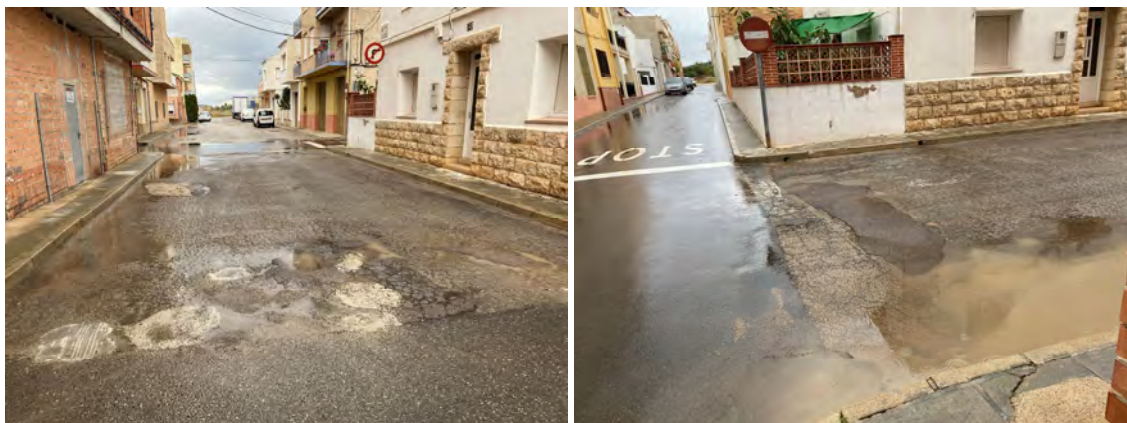
Imatge 12, 13. Estat actual carrer Entença (entre C/Doctor Robert i C/Salvador Vila).
