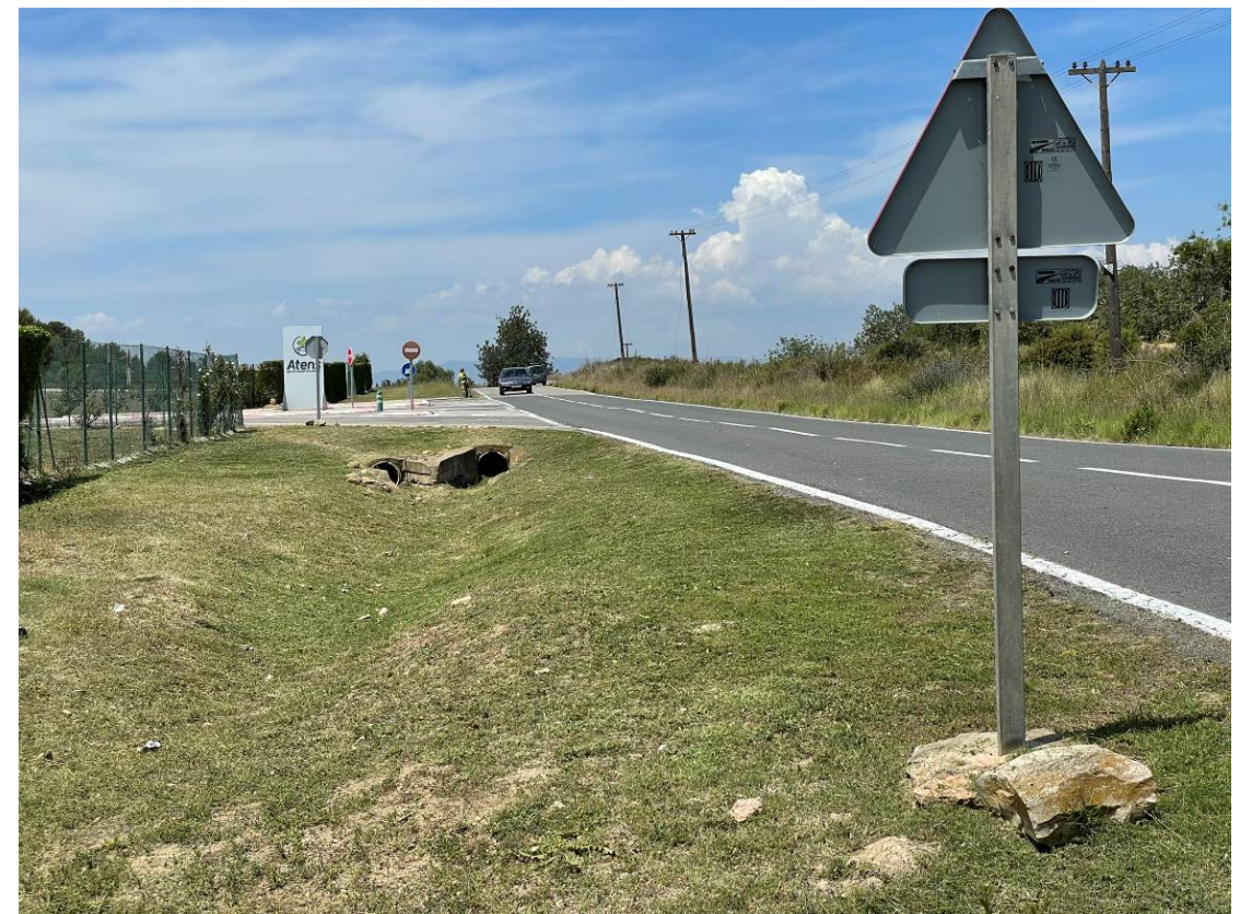
FOTOGRAFIA 12. Obres de drenatge a conservar.
