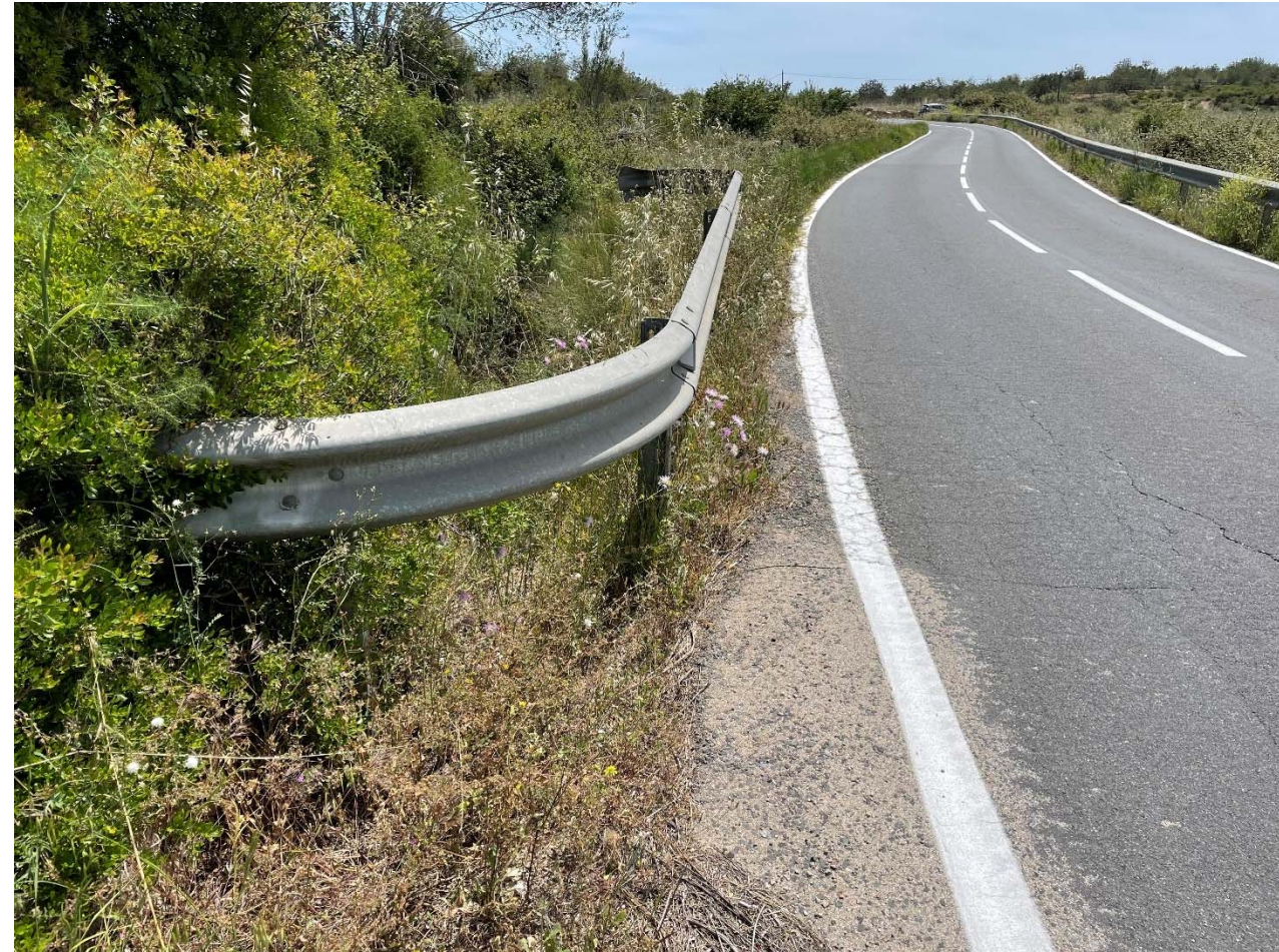
Exemple d'obra de drenatge existent on desaiguar.
