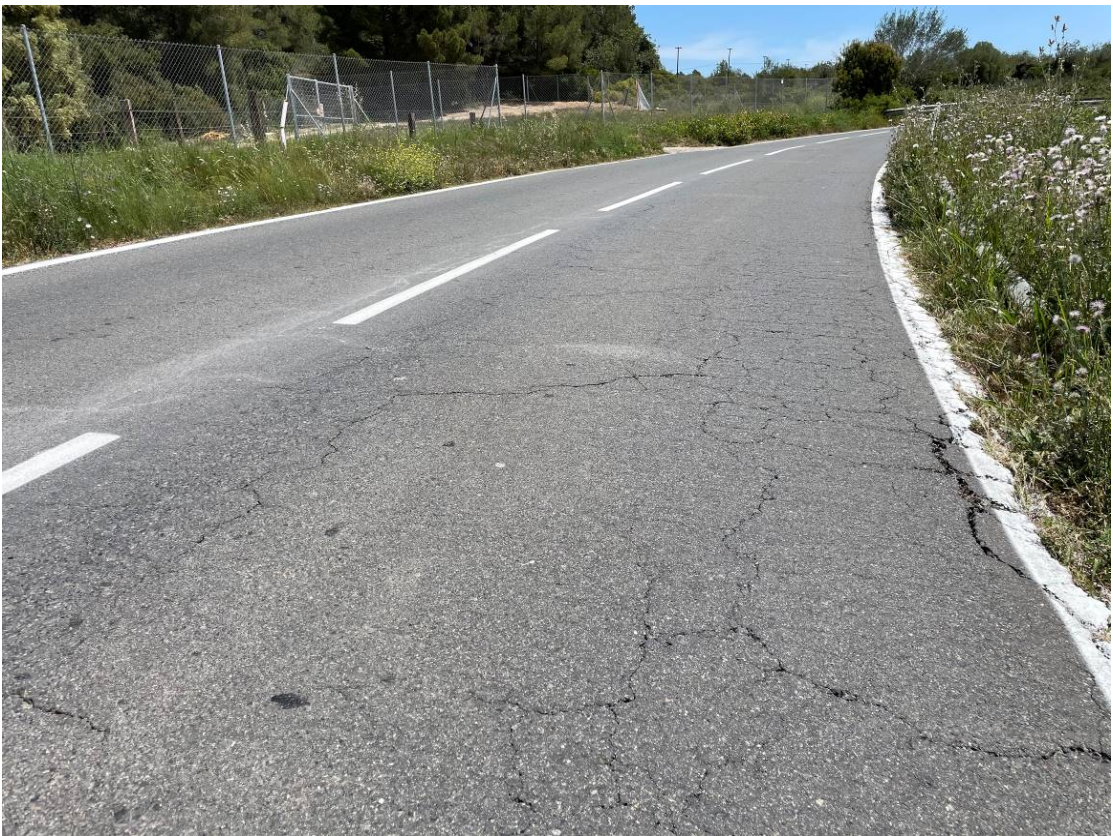
FOTOGRAFÍA 16. Estat de l'asfalt i localització de cuneta.
