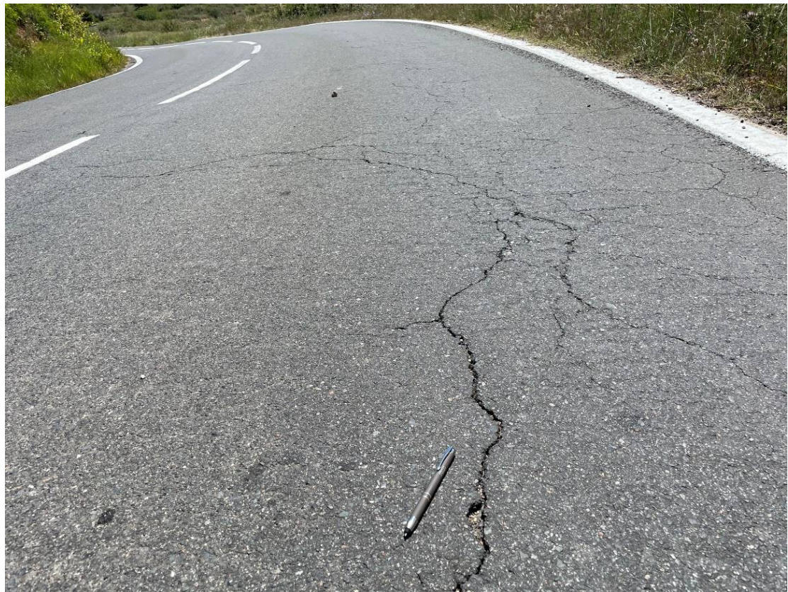
FOTOGRAFÍA 14. Estat de l'asfalt i localització de cuneta.
