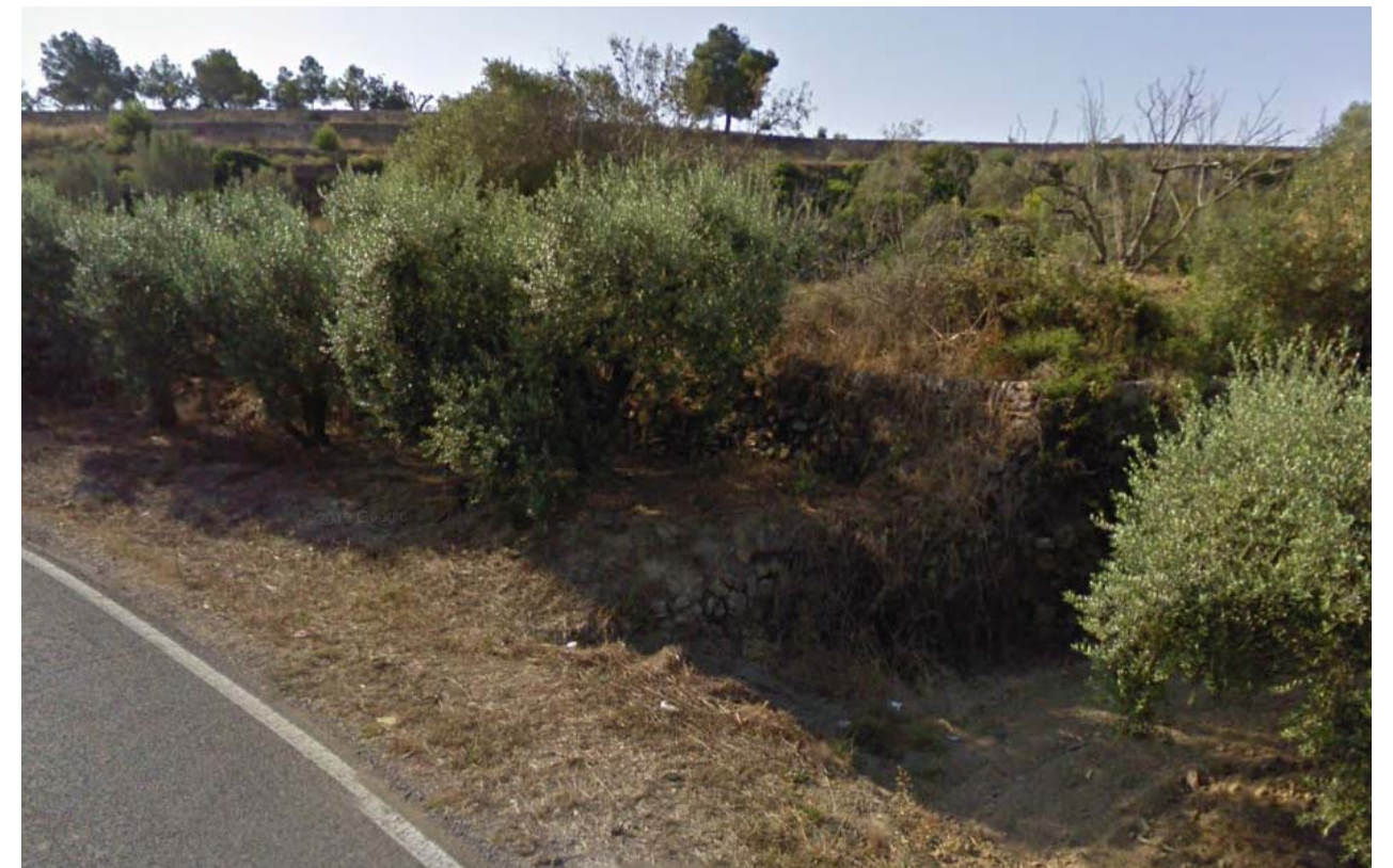
Punt de finalització de cuneta i abocament de col·lector a peu de terraplè.
