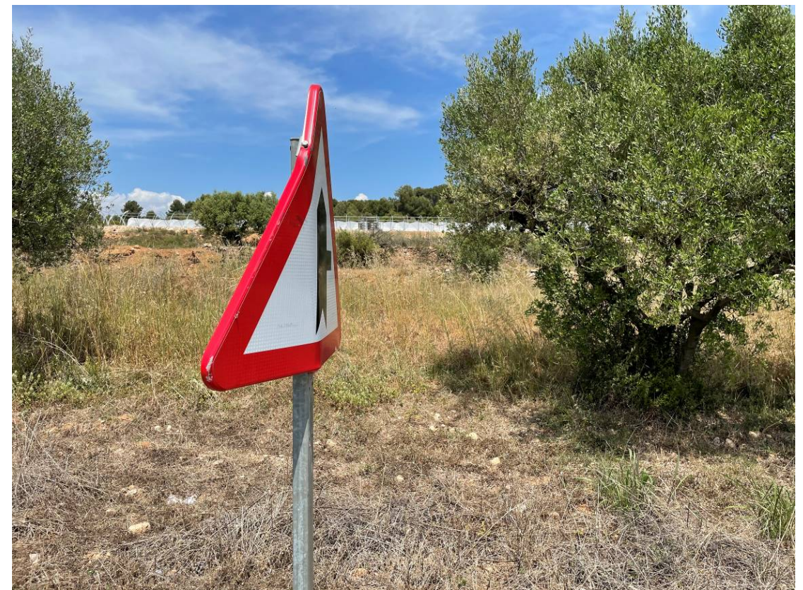
FOTOGRAFIA 24. Senyal en mal estat a ser substituïda.
