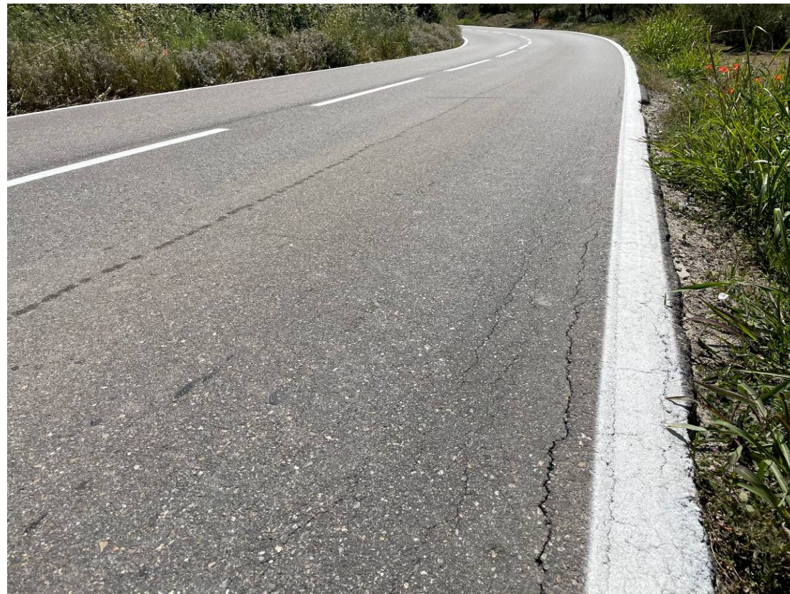
FOTOGRAFIA 2. Estat de l'asfalt existent i localització de cunetes.
