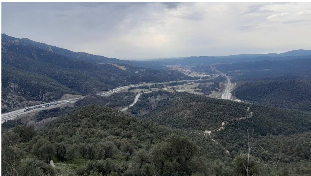
Vista del corredor d'infraestructures des de dalt de Panissars. En primer terme, els boscos de sureda que es treballaran.
